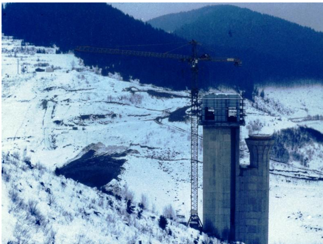
Fotografia č. 21: Výstavba hrádze Nová Bystrica (po roku 1983). 202
