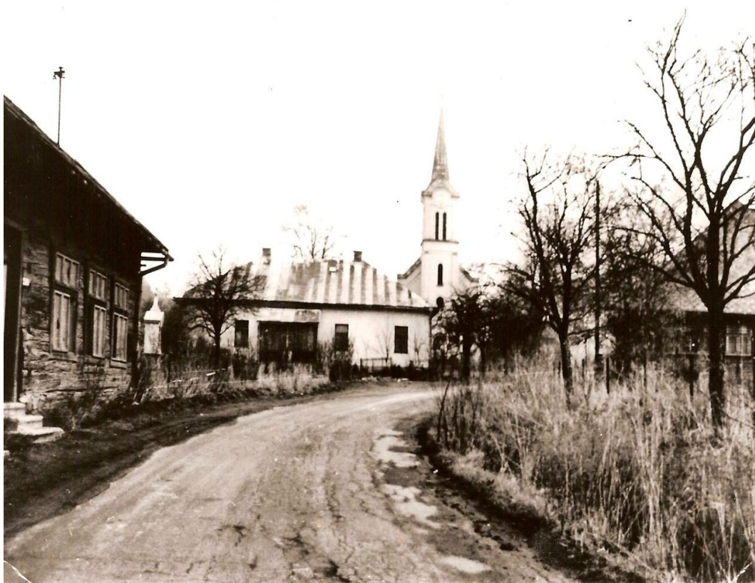
Fotografia č. 20: Pohľad na kostol v Riečnici tesne pred zánikom obce (1986?). 201
