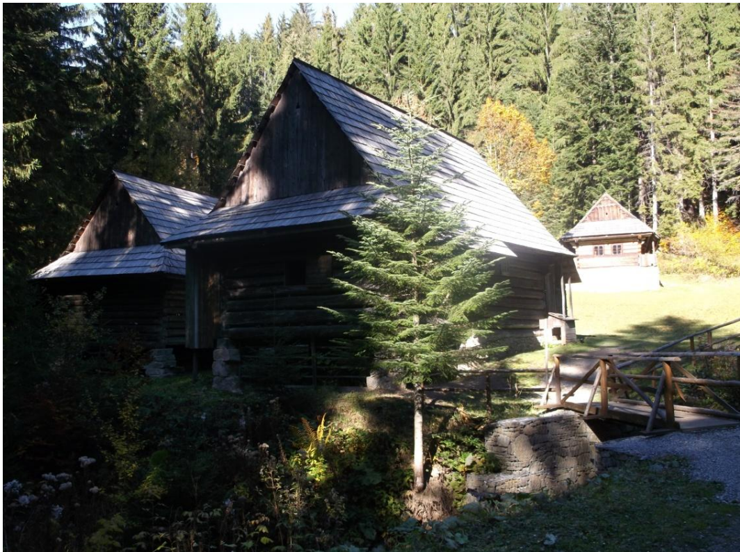
Fotografia č. 41: Hospodárske stavby od Hruškuliaka umiestnené v Múzeu kysuckej dediny vo Vychylovke (september 2013). 222
