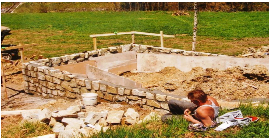
Fotografia č. 44: Výstavba kaplnky Božského Srdca Ježišovho v Harvelke (2006?). 225
