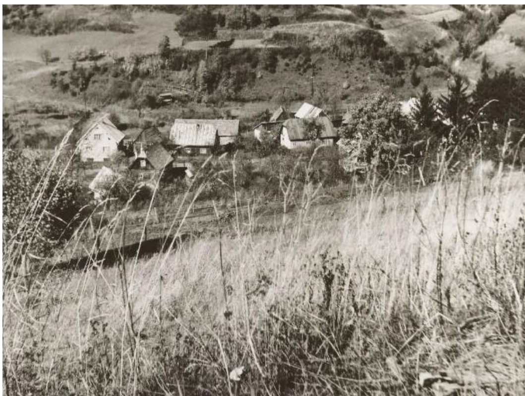
Fotografia č. 8: Osada Košútovia v Riečnici, pohľad z cintorína. 189
