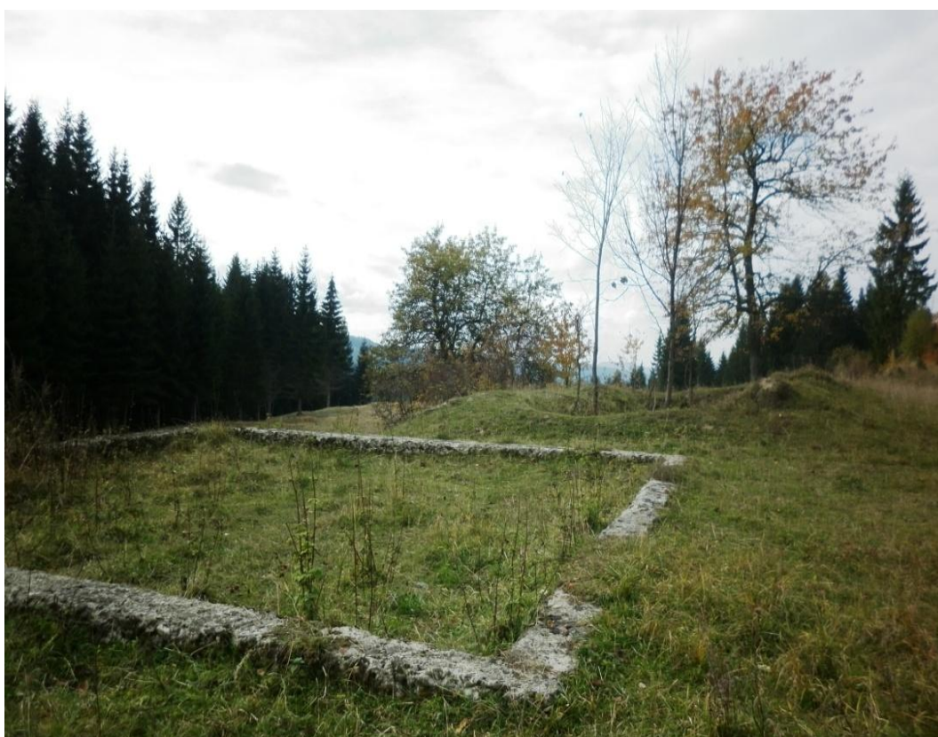
Fotografia č. 33: Základy harvelského domu ako jediná pamiatka bývalej stavby (november 2013). 214
