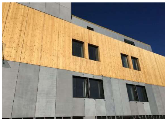
Obrázek 6 Obklad z masivních třívrstvých desek
