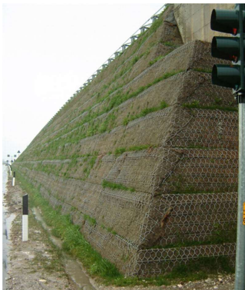
Obrázek 33: Green Terramesh s částečnou vegetací (Maccaferri, 2015)
