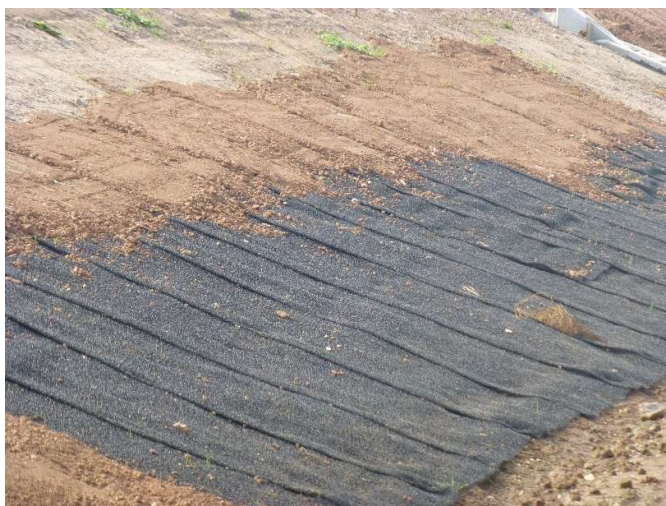
Obrázek 24: Aplikace gerohože na svah (Kozák, 2012)
