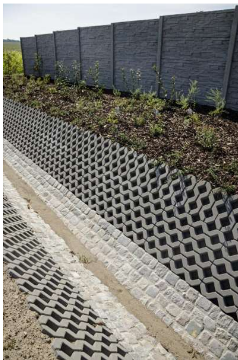
Obrázek 34: Zpevněný příkop betonovou dlažbou (Prefa Brno a.s., © 2019)
