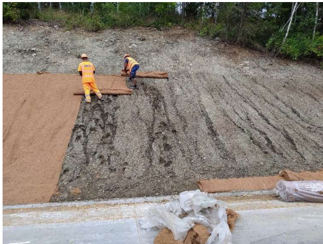
Obrázek 49: Instalace protierozní ochrany na porušený svah (Kozák, 2021)
