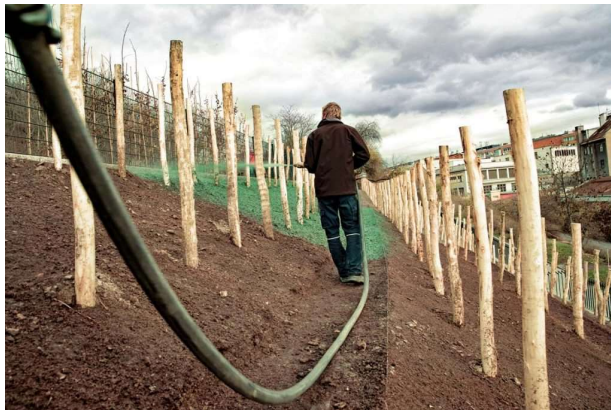
Obrázek 16: Aplikace hydroseevu na svah (GABRIEL, 2019)
