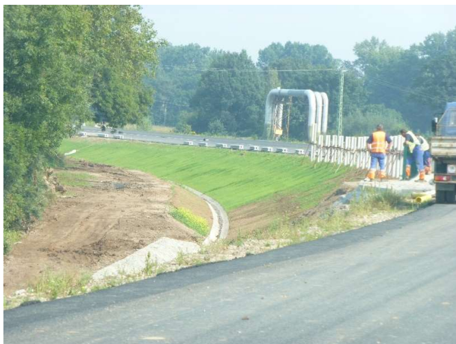
Obrázek 25: Zatravněný svah za pomoci georochože (Kozák, 2012)
