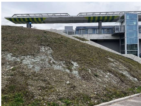
Obrázek 47: Narušení povrchu svahu na svazích nádraží Zahradního Města (Nývlt, 2023)
