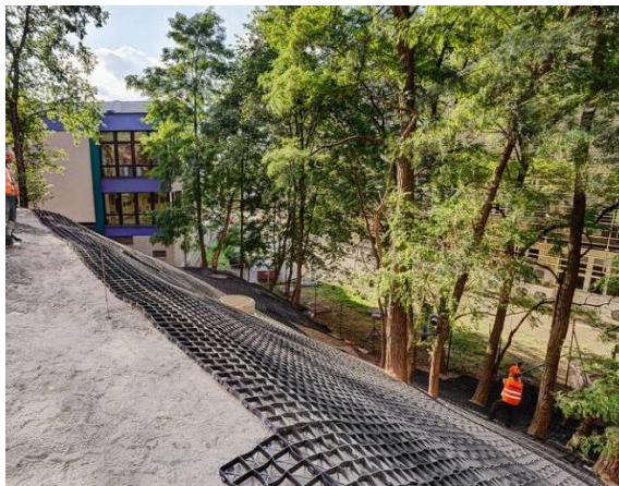
Obrázek 38: Instalace plastové zatravnovací dlaždice (PROSTAVBU, © 2022)
