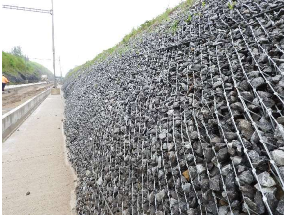
Obrázek 30: Instalovaný systém z 3D panelů připravený na nástřik humusoidní vrstvy (Kozák, 2022)
