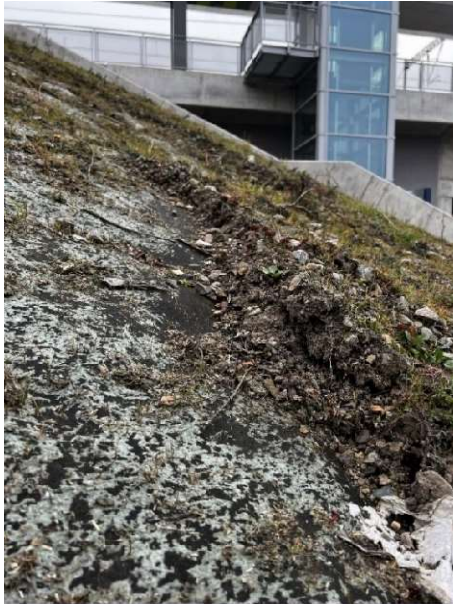
Obrázek 48: Tloušťka nahrnuté zeminy s hydroosevem na geotextilii (Nývlt, 2023)
