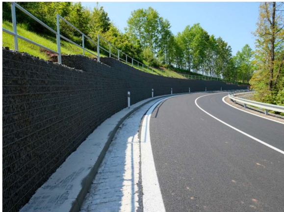
Obrázek 32: Gabionová zeď (ŘSD, 2022)
