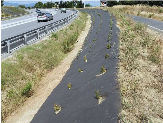
Obrázek 46: Geotextilie s bodovou výsadbou keřů (GEOMAT, © 2023)
