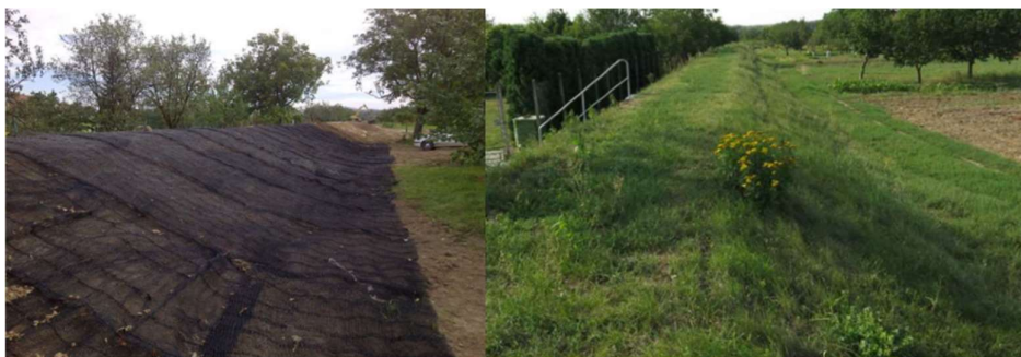
Obrázek 50: Příklad nepatrné instalace georochože v přírodě (MARCADOR, 2022)
