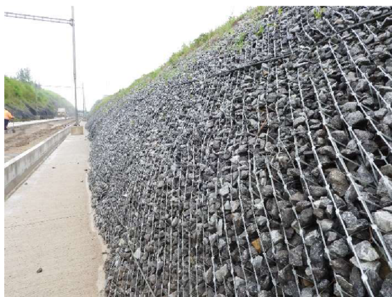
Obrázek 30: Instalovaný systém z 3D panelů připravený na nástřik humusoidní vrstvy (Kozák, 2022)
