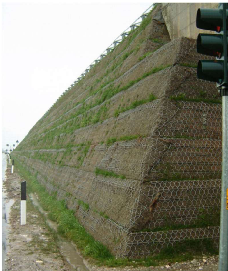
Obrázek 33: Green Terramesh s částečnou vegetací (Maccaferri, 2015)
