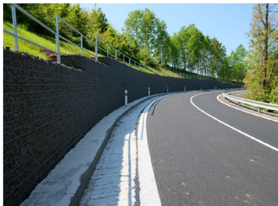
Obrázek 32: Gabionová zeď (ŘSD, 2022)
