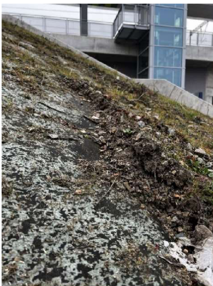
Obrázek 48: Tloušťka nahnuté zeminy s hydroosevem na geotextilii (Nývtl, 2023)
