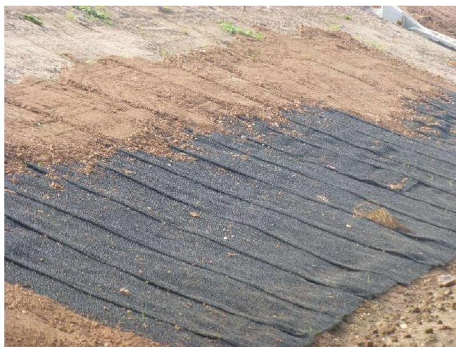
Obrázek 24: Aplikace gerohože na svah (Kozák, 2012)
