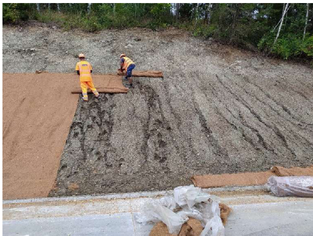
Obrázek 49: Instalace protierozní ochrany na porušený svah (Kozák, 2021)
