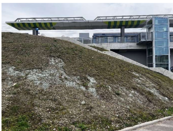
Obrázek 47: Narušení povrchu svahu na svazích nádraží Zahradního Města (Nývt, 2023)
