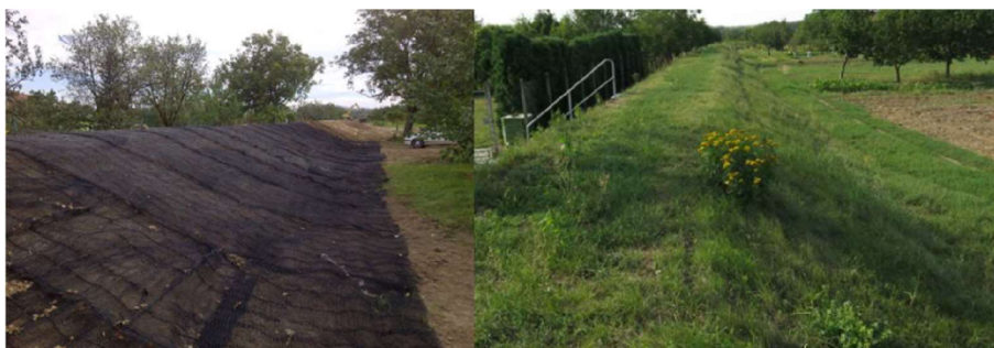
Obrázek 50: Příklad neaptné instalace georochože v přírodě (MARCADOR, 2022)
