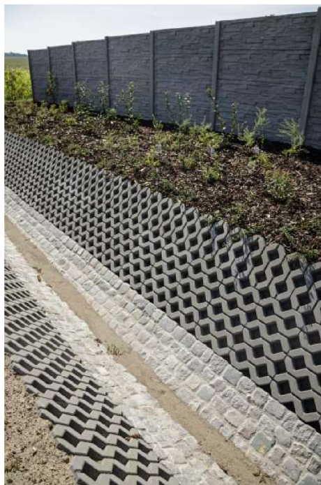
Obrázek 34: Zpevněný příkop betonovou dlažbou (Prefa Brno a.s., © 2019)
