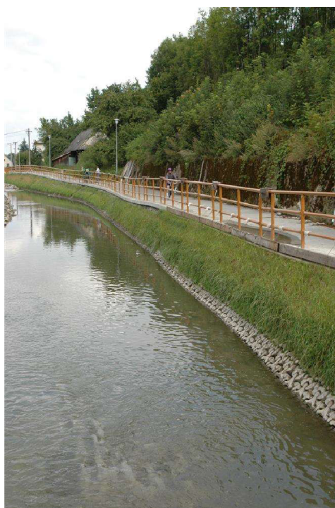
Obrázek 36: Zazeleněný svah vodního toku kloubovou dlažbou (STAVOBLOCK SYSTEM, © 2023)
