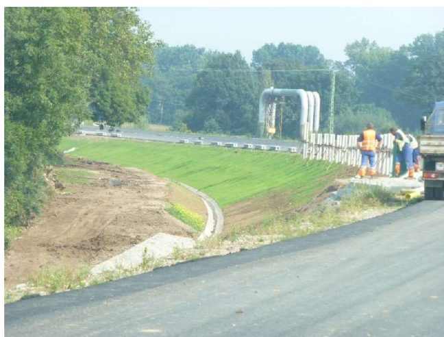
Obrázek 25: Zatravněný svah za pomoci georochože (Kozák, 2012)
