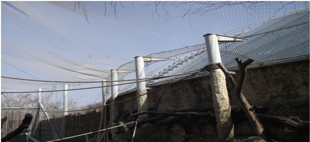
Obr. č. 58. Uchycení speciální sítě k pavilonu
