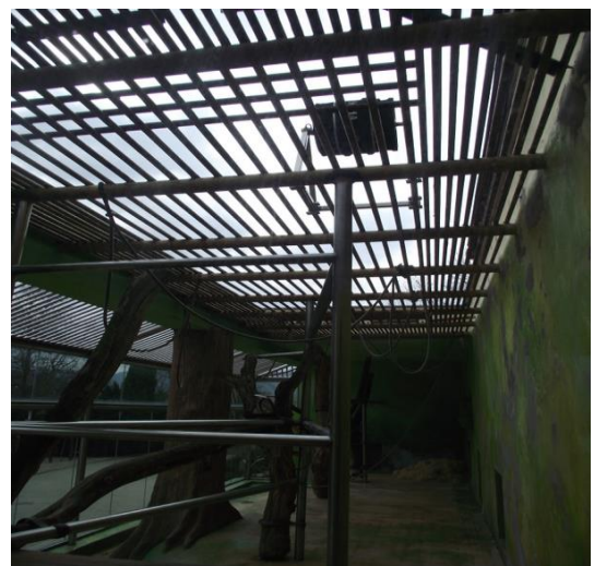
Obr. č. 5. Konstrukce stropu venkovního výběhu
