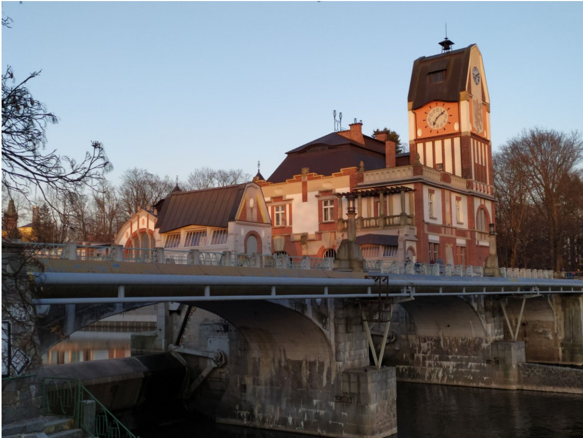
Obrázek 3 Malá vodní elektrárna Labe s jezem Hučákem
