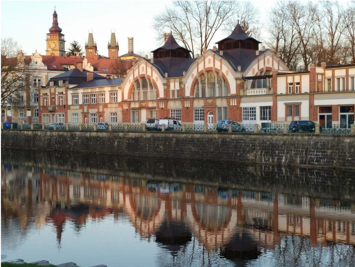
Obrázek 4 Malá vodní elektrárna Labe
