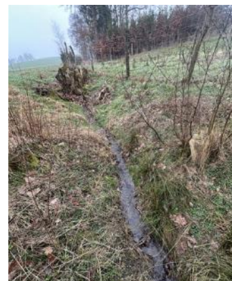
Obr. 71: Úsek P4, proti proudu
