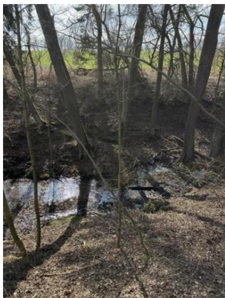
Obr. 43: Úsek P2, proti proudu
