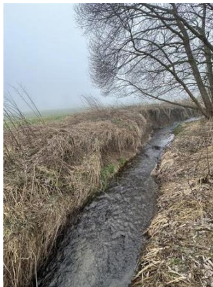
Obr. 90: Úsek 13, proti proudu
