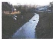
Sítňová stabilizace dišlby z lomového kamene se st. opavními > 7,00 (na malém úseku) Hodnota: 7,5000
