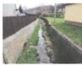
Opěrné zdi betonové, ležecové spod. Hodnota: 10
