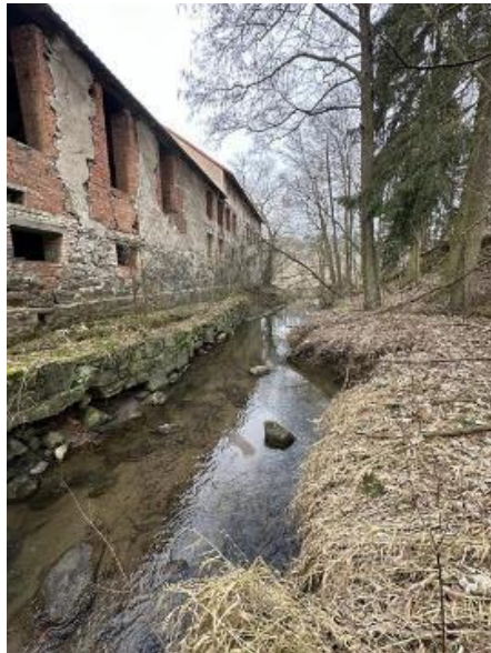
Obr. 11: Úsek 1, po proudu
