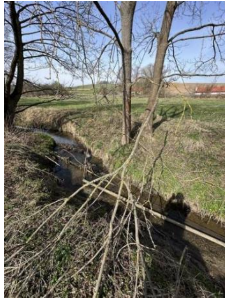
Obr. 96: Úsek 14, proti proudu
