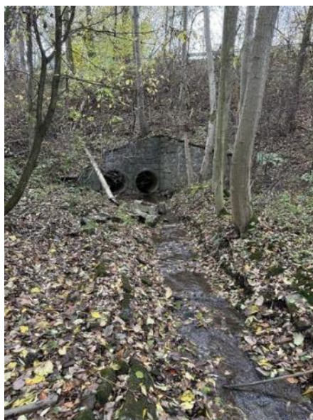
Obr. 107: Úsek 16, silniční násep
