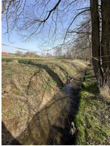
Obr. 95: Úsek 14, po proudu
