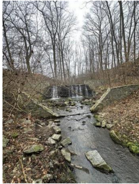
Obr. 79: Úsek 12, proti proudu
