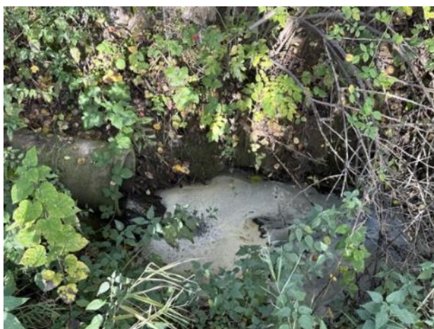
Obr. 122: Úsek 19, proti proudu
