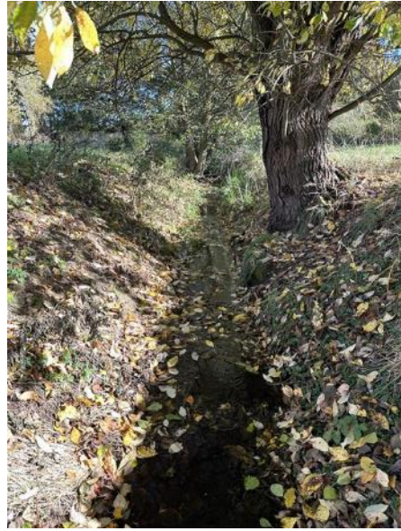
Obr. 119: Úsek 18, po proudu
