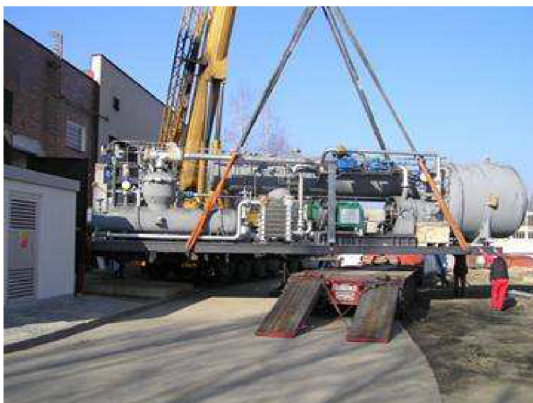
Obr. 13 ORC jednotka při montáži [16]
