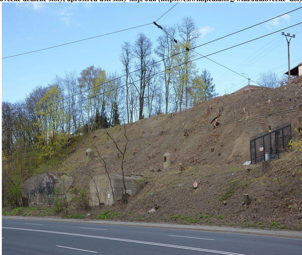
Obrázek 22 - Odkrytá stráž vrchu Jaklovec nad Bohumínskou ulicí ve Slezské Ostravě: vpravo ústí Jaklovecké dědičné štoly, uprostřed ústí štoly sloje Jan ( https://cs.wikipedia.org/wiki/Jaklovecké_doly )
