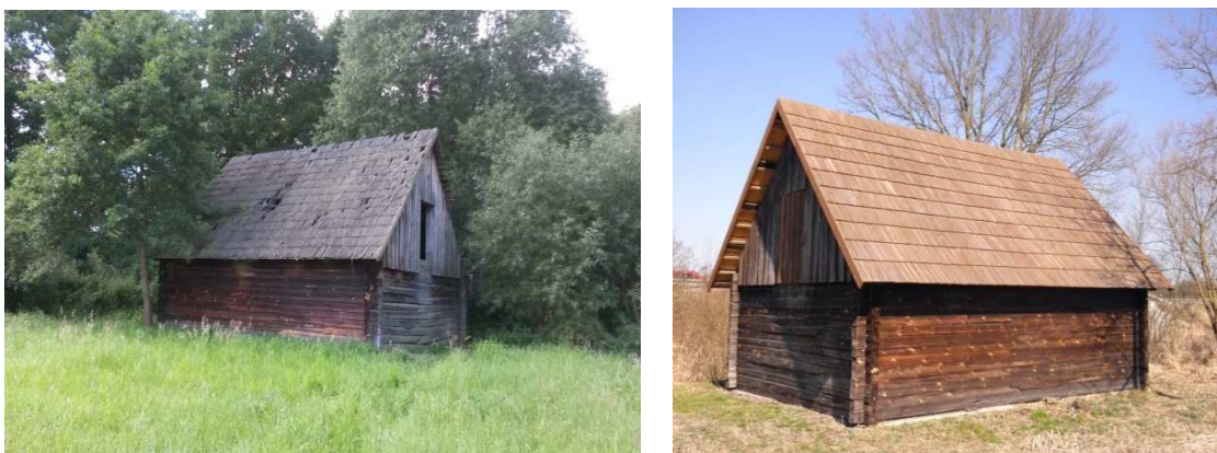
Obrázek 64: Seník v havarijním stavu a seník po rekonstrukci (autorka, 2015)
