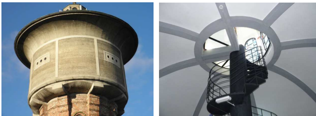
Obrázek 56: Kopule vodárny, vnější a vnitřní pohled (autorka, 2015)
