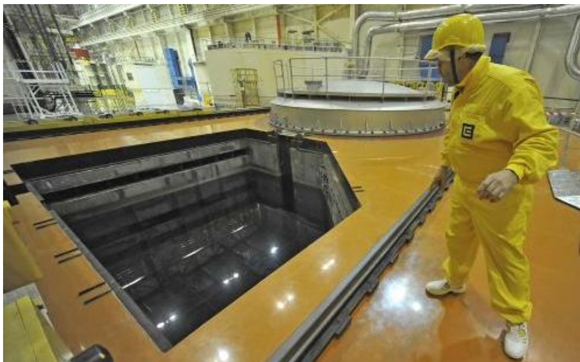
Obr. 4: Bazén vyhořelého paliva v elektrárně (13)
