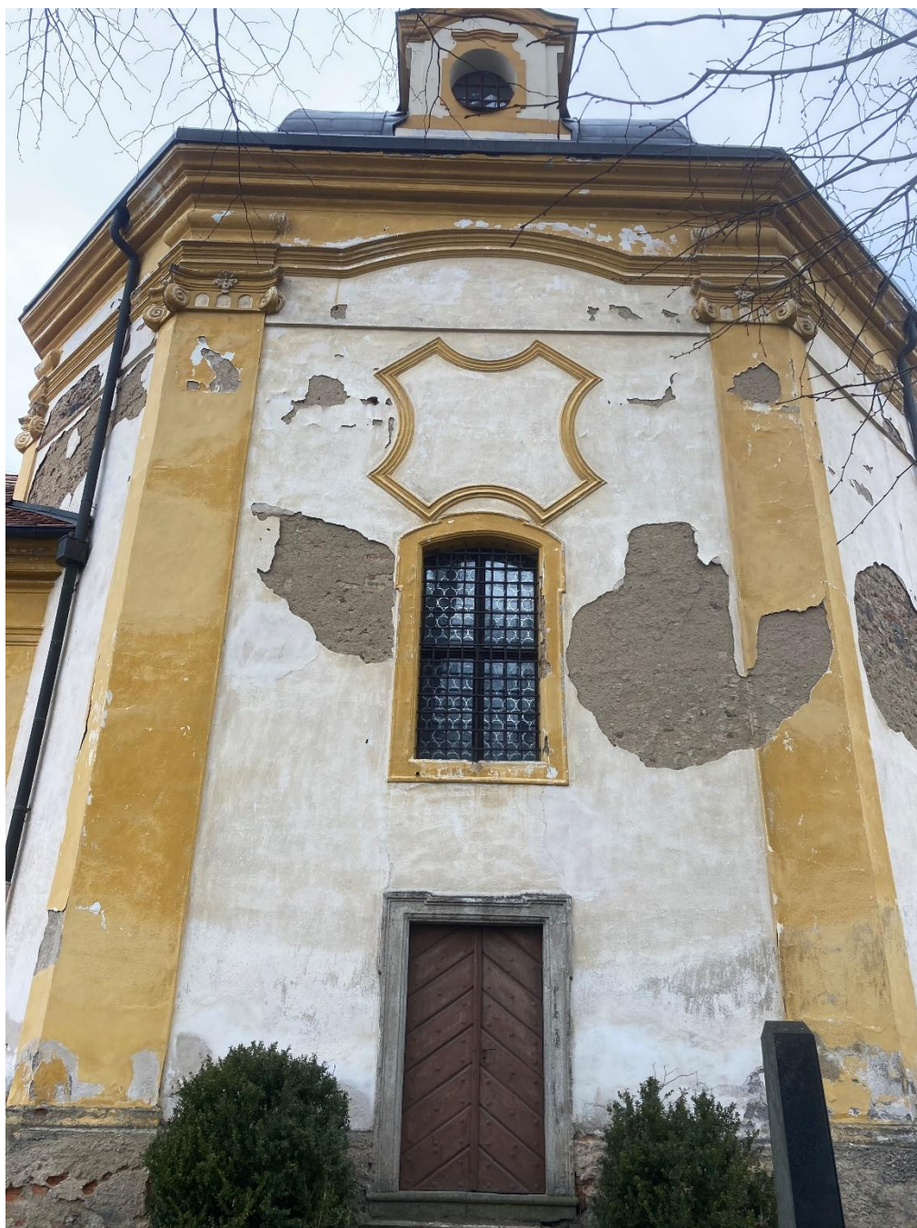
Obr. 13 Pohled z jižní strany, vstup do presbytáře
