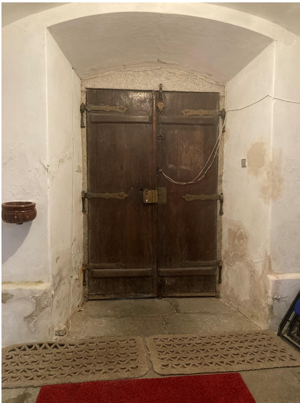
Obr. 15 Původní vstupní dveře – západní průčelí
