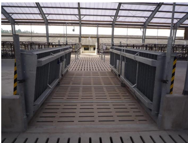
Obrázek 4: Zvednutí hydraulického mostu, foto: Michaela Novotná
