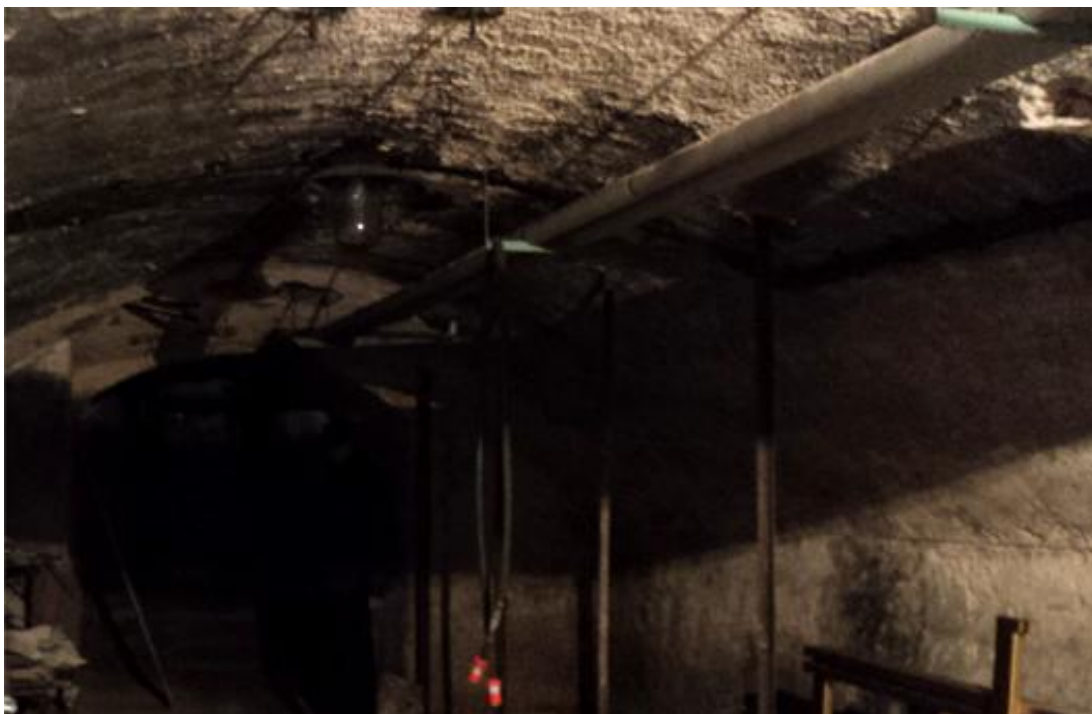
Příloha č. 47. Pohled do prostorů kostelní krypty. Viditelný je původní vchod z prostoru lodi kostela. Fotografie z roku 2015.
