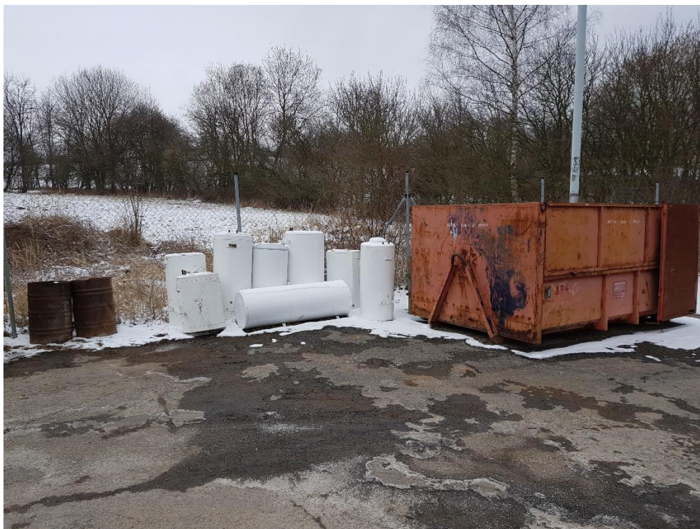
Obrázek 8 - Nevhodné umístění bílé elektroniky a poškozený povrch (prostor bývá před svozem zcela zaplněný bílou elektronikou); (autor práce, 2018).
