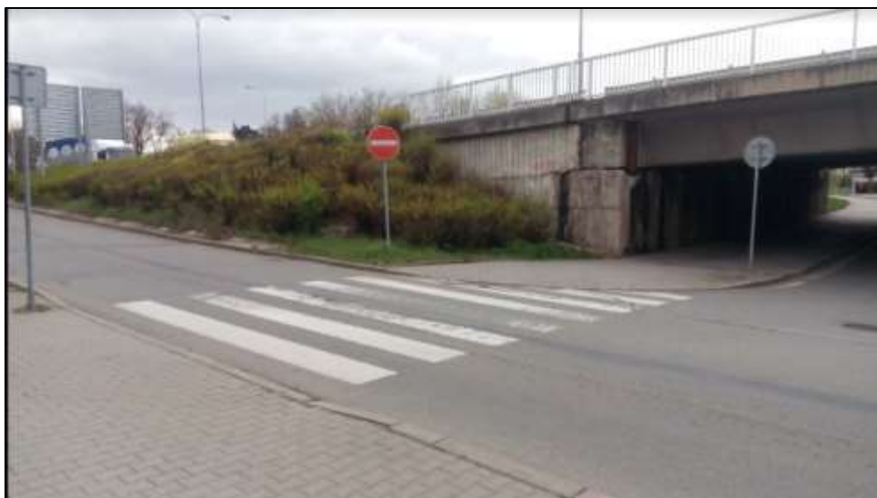
Obr. 83: Fotografie přechod u vlakového nádraží Královo pole (zdroj: vlastní)
