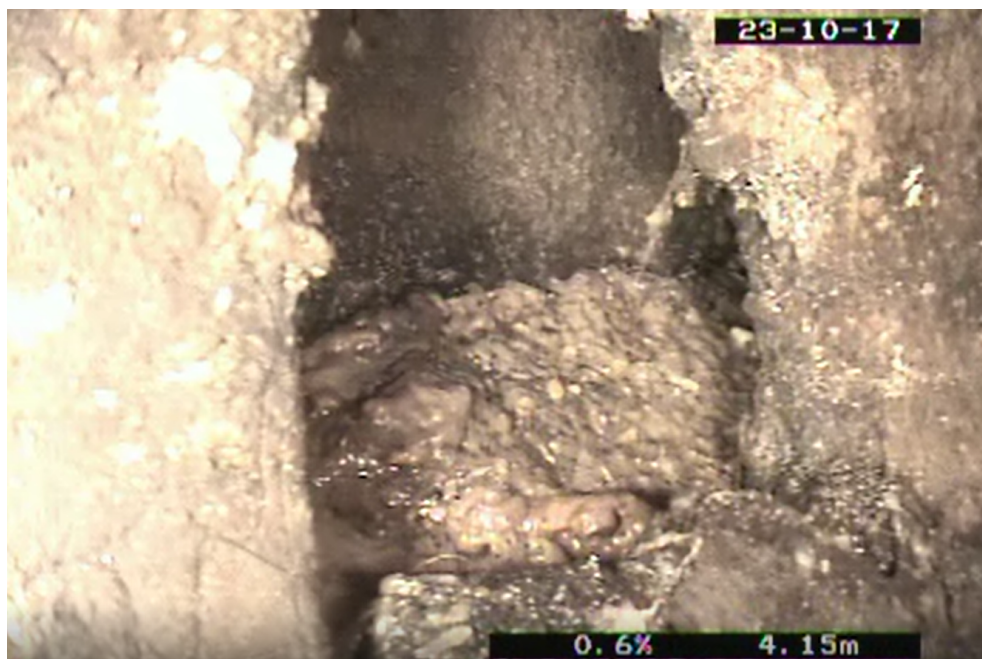
Obr. 5.7: Porucha 3 – Vypadlý střepe
