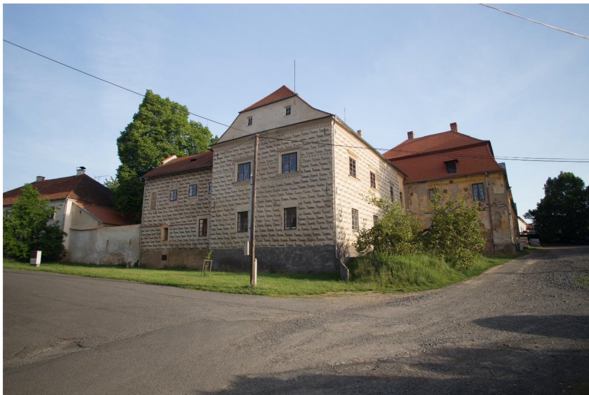
Příloha č. 6: Současný pohled na vodní hrad Švihov.
