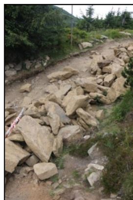
Obr. 20: rekonstrukce poškozeného úseku Zdroj: vlastní fotografie
