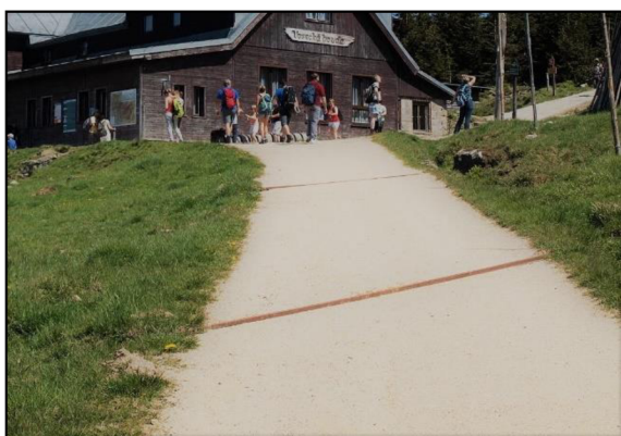
Obr. 12: Detail úseku Vosecká bouda – Pod Voseckou boudou. Zdroj: vlastní fotografie
