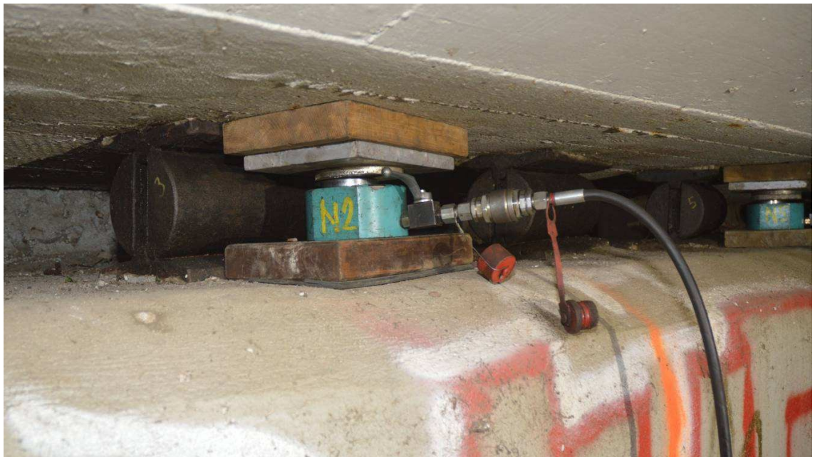
Obr. 4.16 Instalace hydraulických zvedáků pro částečné odlehčení NK
