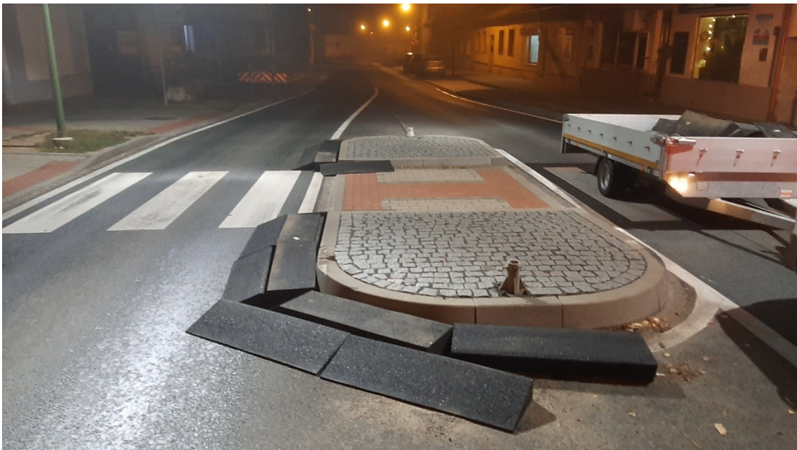
Obr. 4.11 Vypodložení obrubníků ostrůvků přechodů pro chodce, a středových obrub okružních křižovatek
