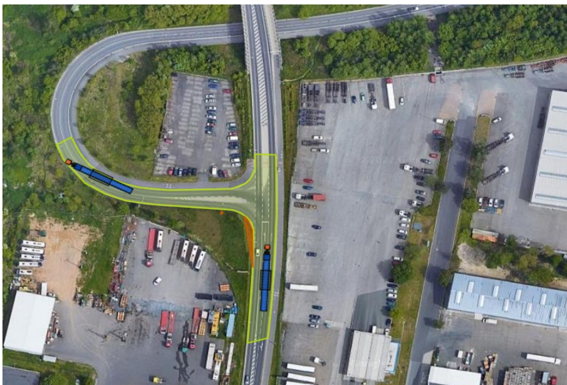
Obr. 4.7 Sjezd dopravní techniky nájezdovou rampou z ulice Regensburská
