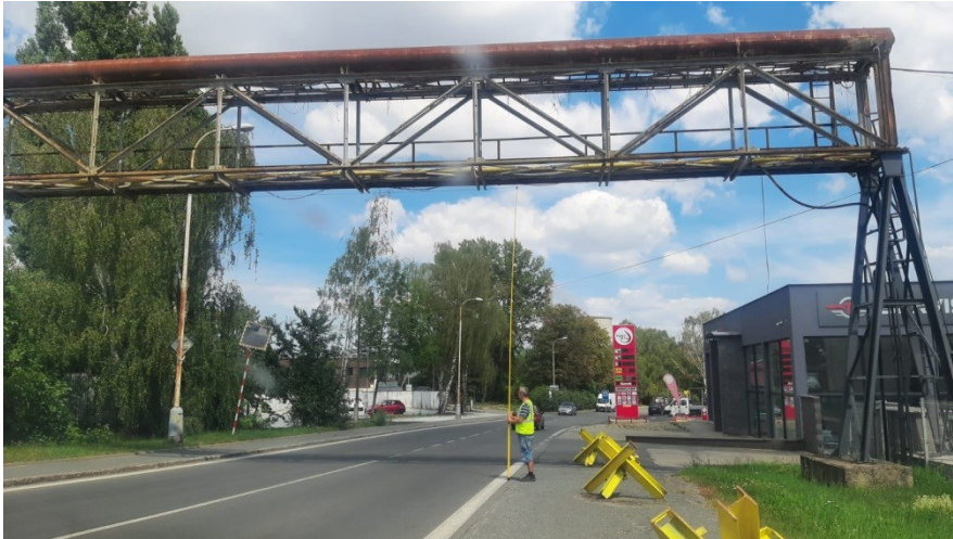
Obr. 3.5 Měření podjezdné výšky měřicí latí
