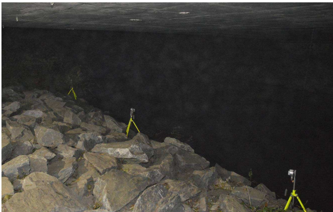
Obr. 4.15 Snímače el. deformací na most přes řeku Mži v Městě Touškově
