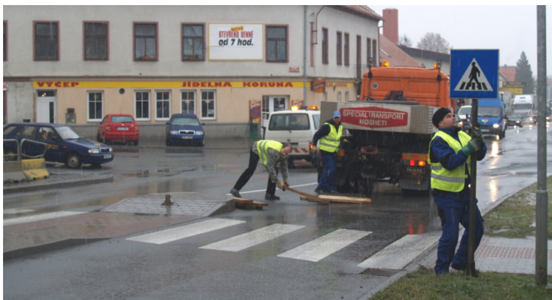
Obr. 2.2 Foto při přepravě a odstranění dopravního značení
