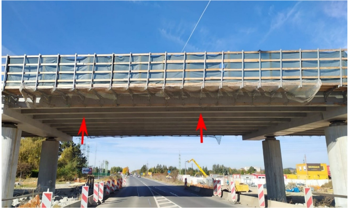
Obr. 4.12 Zajištění demontáže a následné montáže římsových konzol mostního objektu
