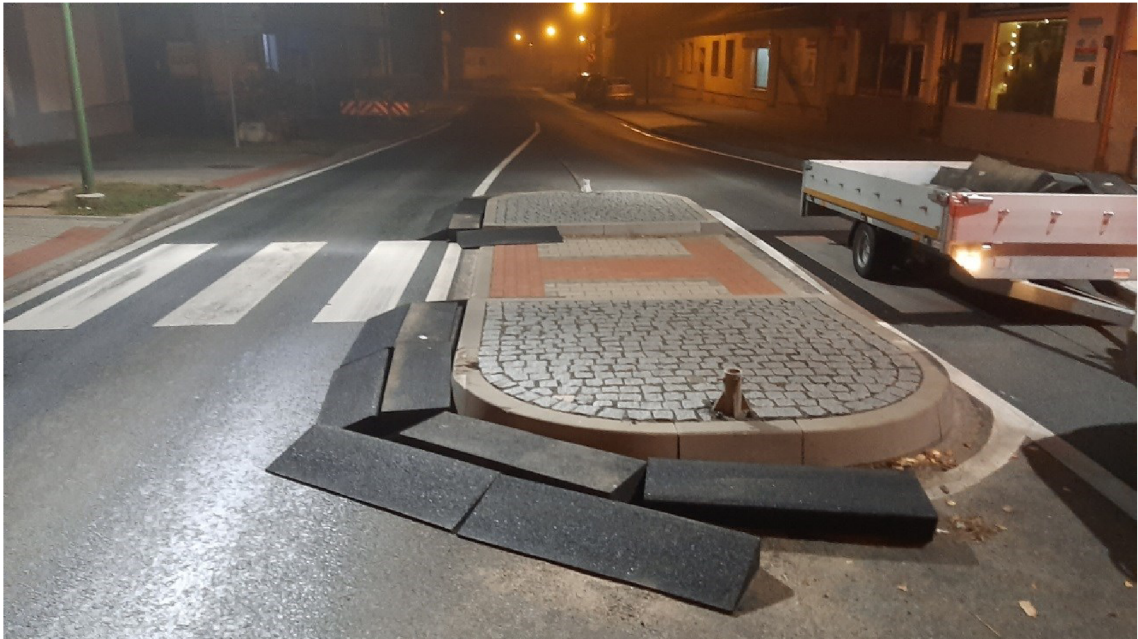
Obr. 4.11 Vypodložení obrubníků ostrůvků přechodů pro chodce, a středových obrub okružních křižovatek
