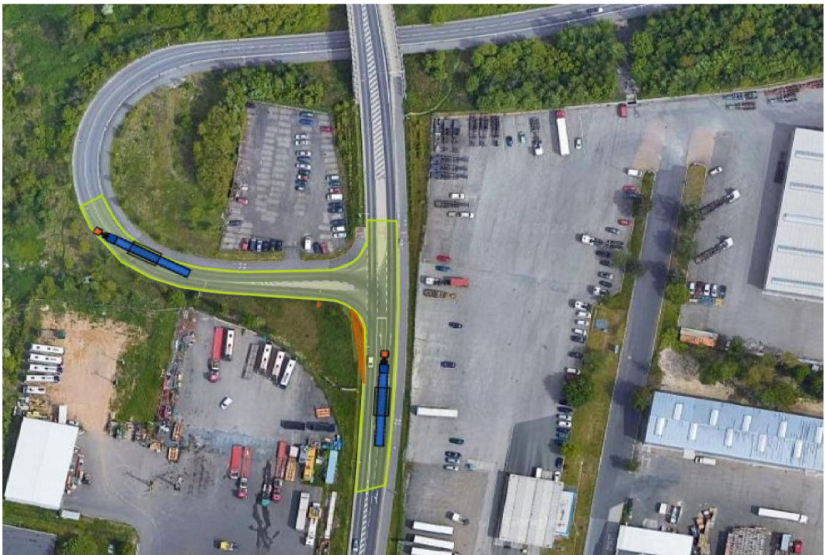
Obr. 4.7 Sjezd dopravní techniky nájezdovou rampou z ulice Regensburská Zdroj: vlastní zpracování
