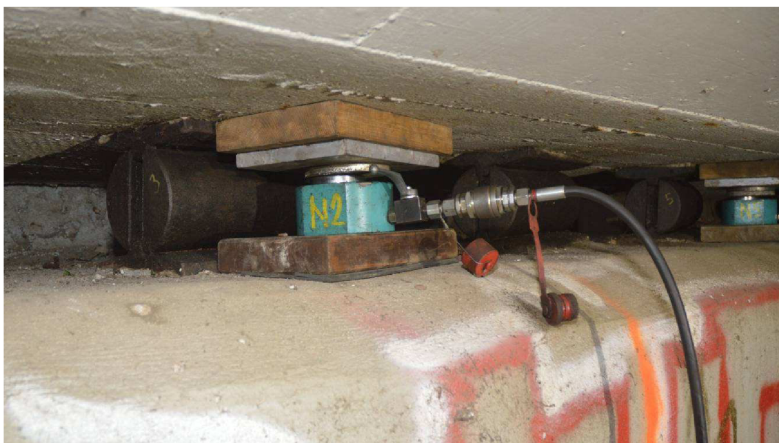
Obr. 4.16 Instalace hydraulických zvedáků pro částečné odlehčení NK
