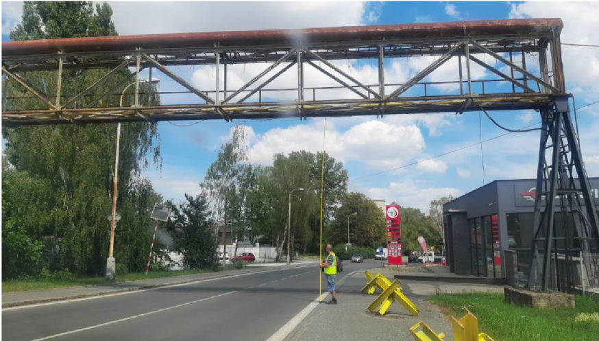
Obr. 3.5 Měření podjezdné výšky měřicí latí
