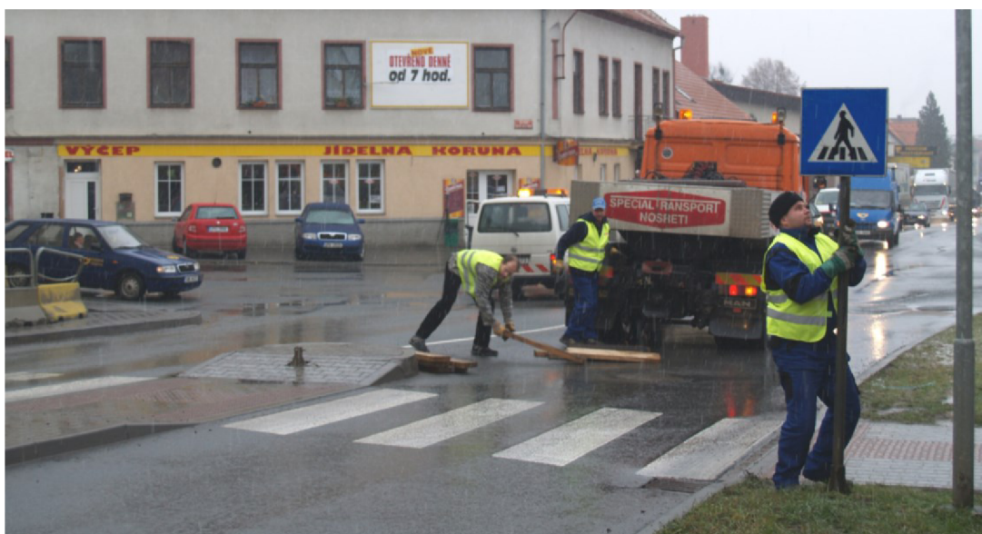
Obr. 2.2 Foto při přepravě a odstranění dopravního značení
