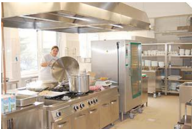
Rekonstrukce školní jídelny
