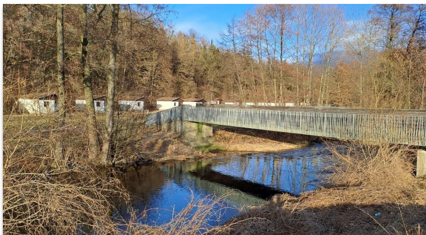
1) Chatová osada z pohledu od fotbalového hřiště (fotografie autorky)
