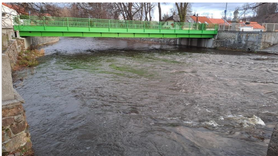
4) Most hlavní silnice číslo 145 foceno od Dolního parku (fotografie autorky)
