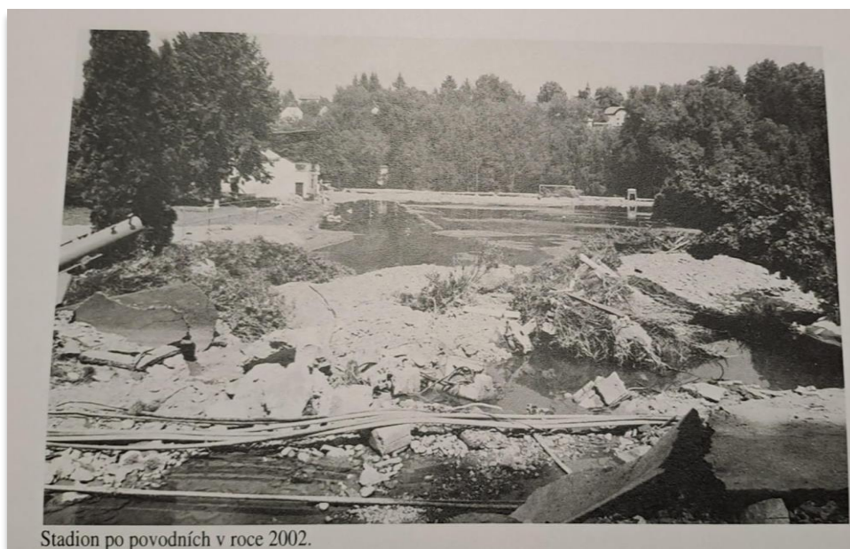
Příloha č. 1: Fotografie fotbalového stadionu a zhroucení lávky pro pěší během povodní 2002 (zdroj: fotografie od Milana Vančury, 2011)
