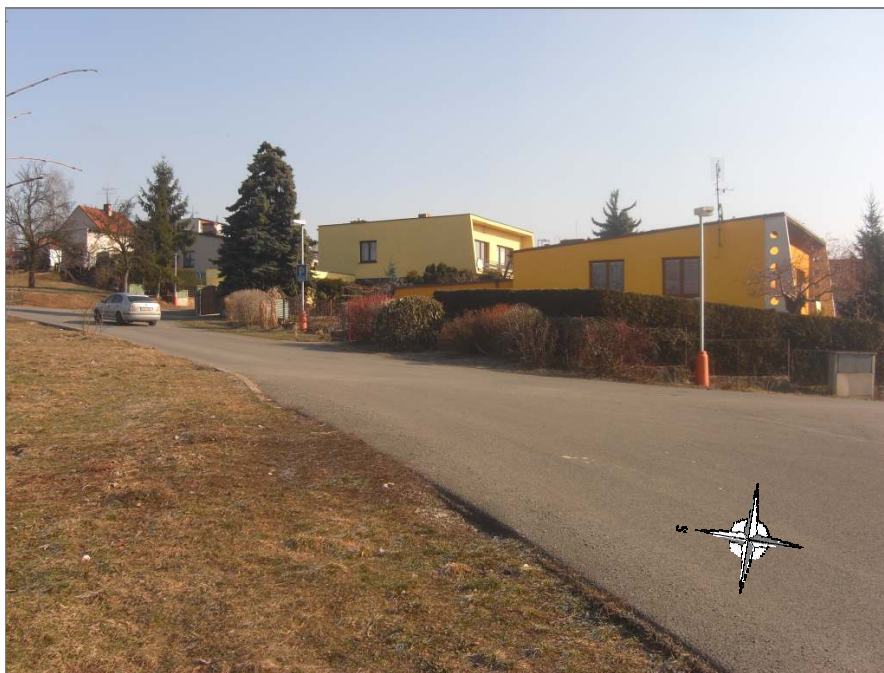
Obrázek č. 3 - Výstavby na jižní straně zájmového území – rovné střechy
