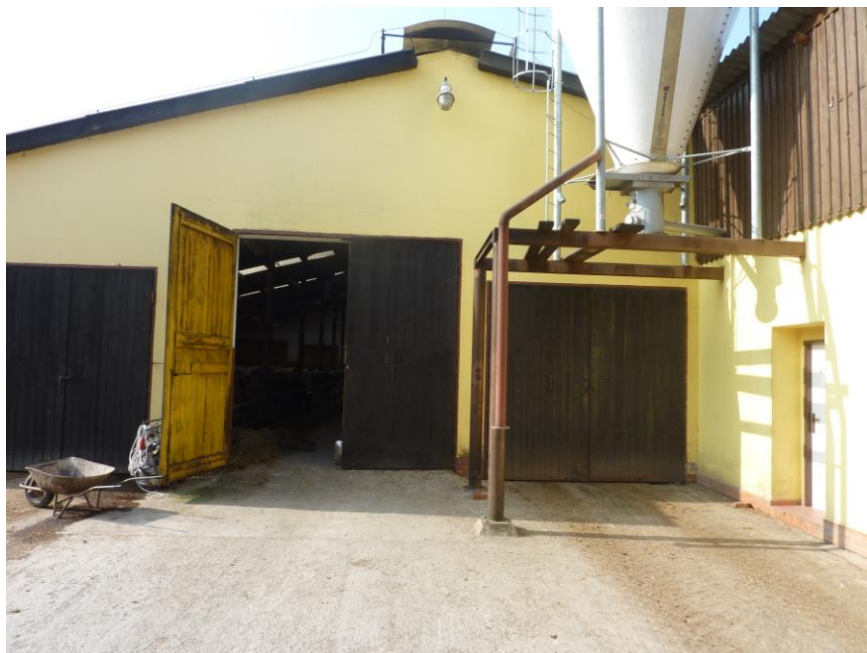
Obrázek 5: Pohled na stáj a na zásobník krmiva
