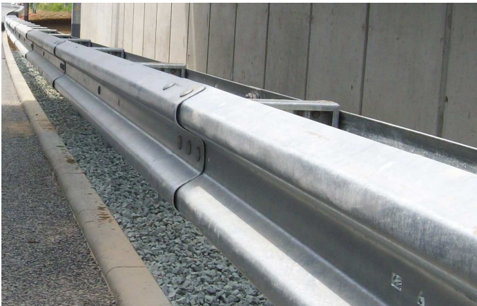
Obrázek č. 19 - Ukázka svodidla KB1 RH1 B. [26]
