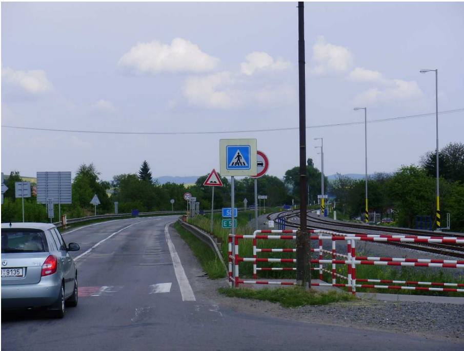
Obrázek č.11 – Špatná viditelnost dopravního značení na hlavní silnici [Zdroj: autorka]
