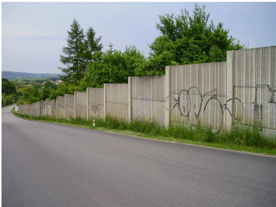
Obrázek č.18 – Protihluková stěna u Rousínova. [Zdroj: autorka]
