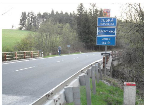
Obr. 12. Lyský průsmyk – silnice II. třídy 49-040 probíhající změněnou lokalitou (BOČEK, 2011)
