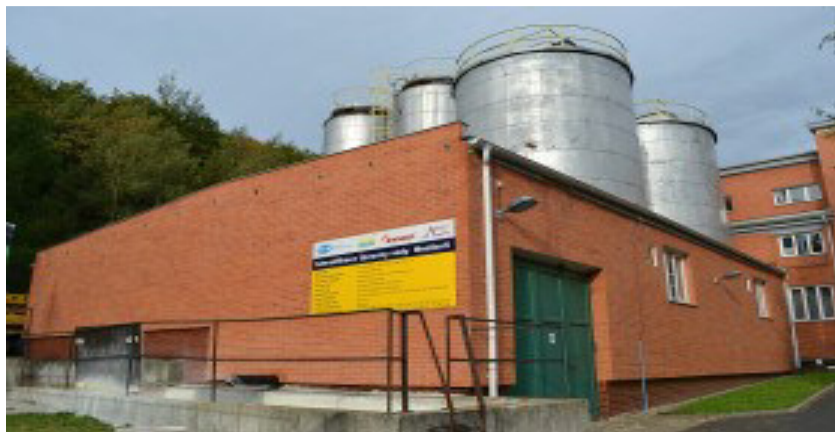
Obrázek 7: Úpravna vody v Meziboří
