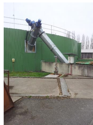
Obrázek 3 – potrubí pro dávkování biomasy do fermentoru
