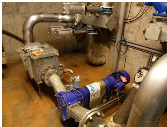
Obrázek 5 – odsiřovací jednotka BPS Drahobudice
