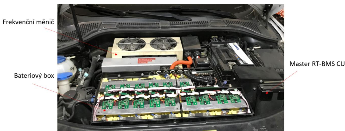
Obr. 15 Pohled do motorového prostoru elektromobilu SuperBEL II.
