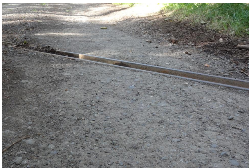
Obr. 3: Svodnice vody
