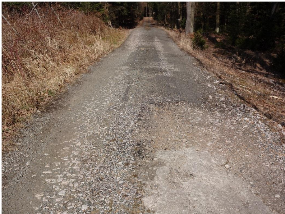
Obr. 28: Druhý úsek oprav
