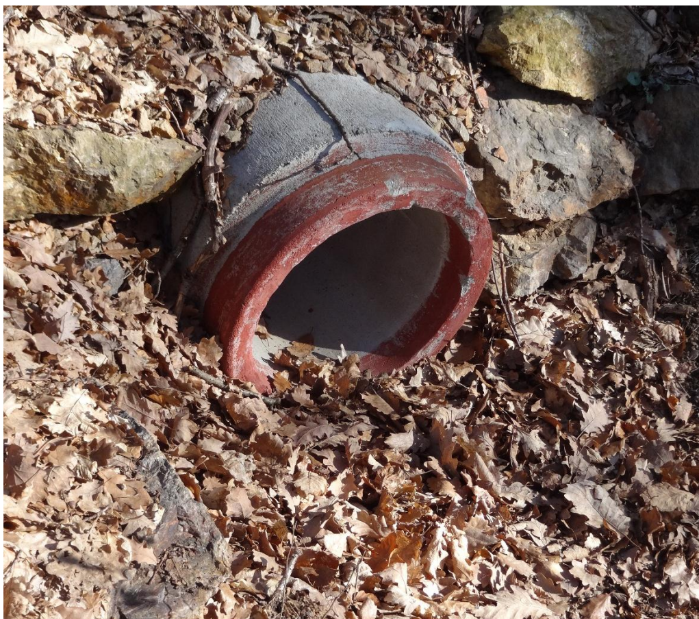
Obr. 23: Betonový propustek na lesní cestě Petrovka
