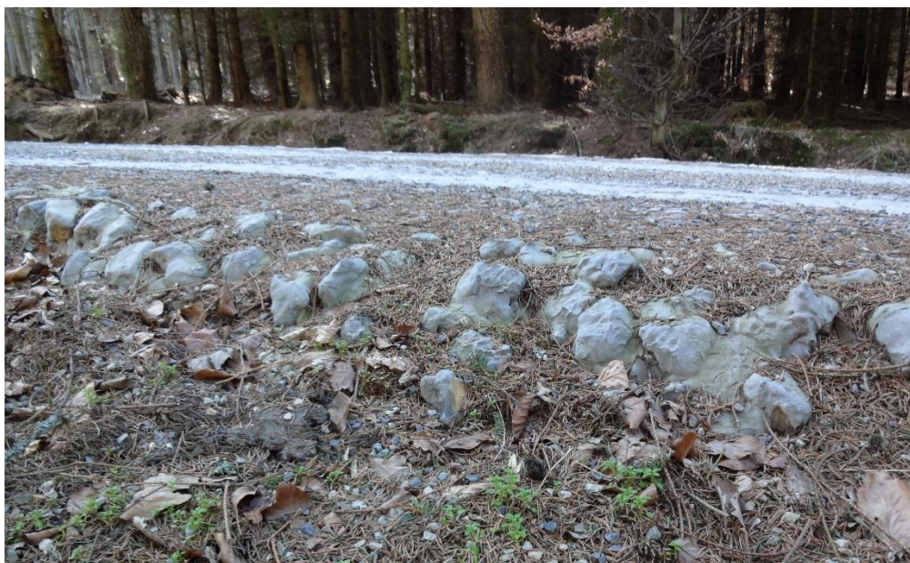
Obr. 30: Opravená lesní cesta Pod Kořeny
