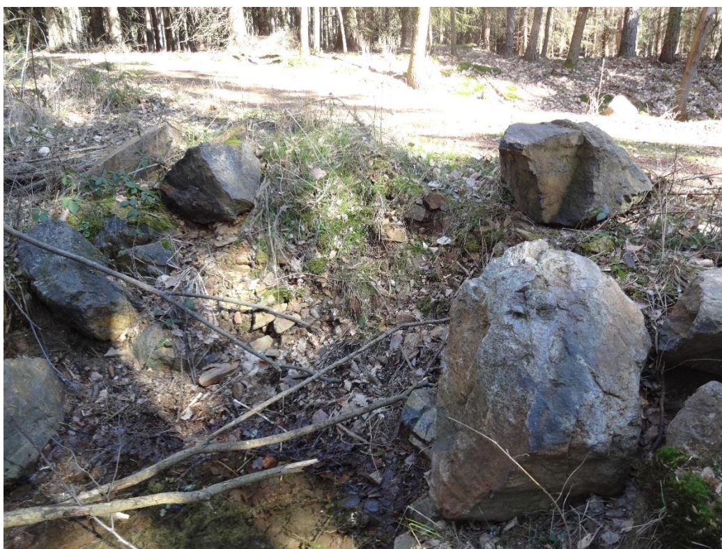
Obr. 19: Drenáž na lesní cestě Jímání
