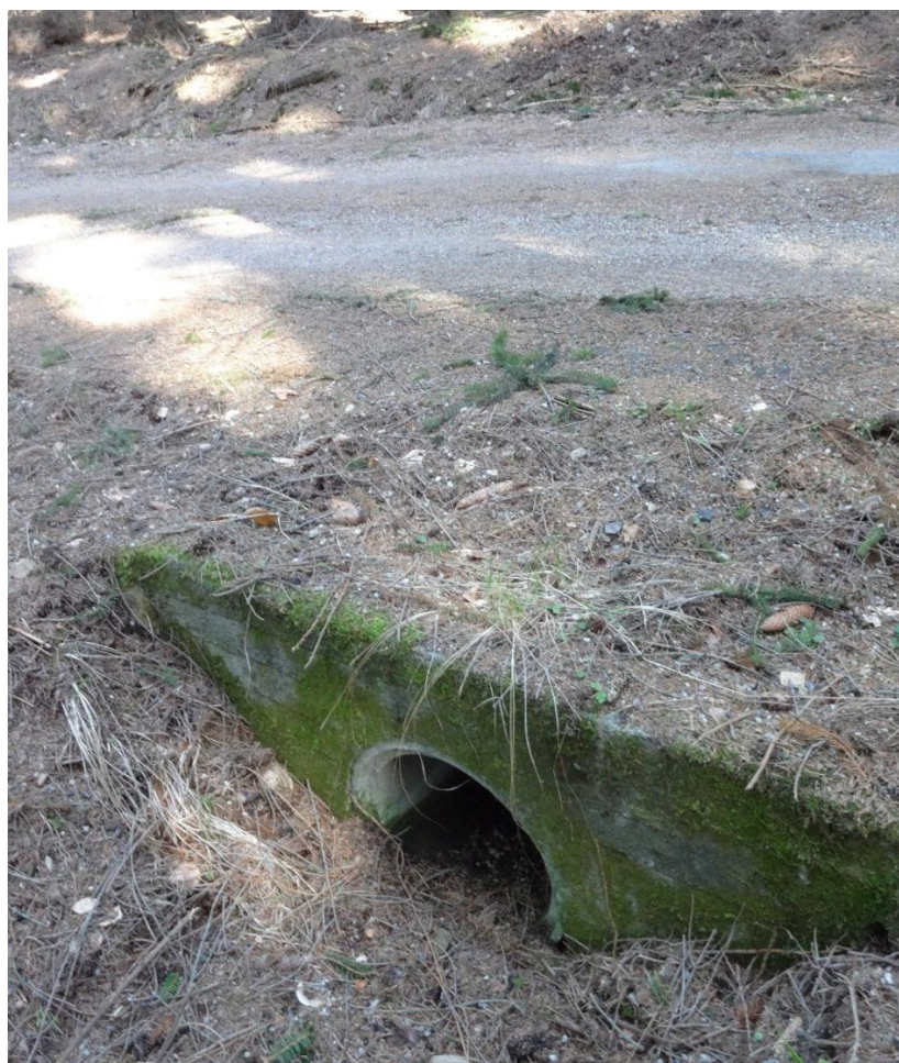
Obr. 29: Lesní cesta Pod Kořeny opatřená propustkem
