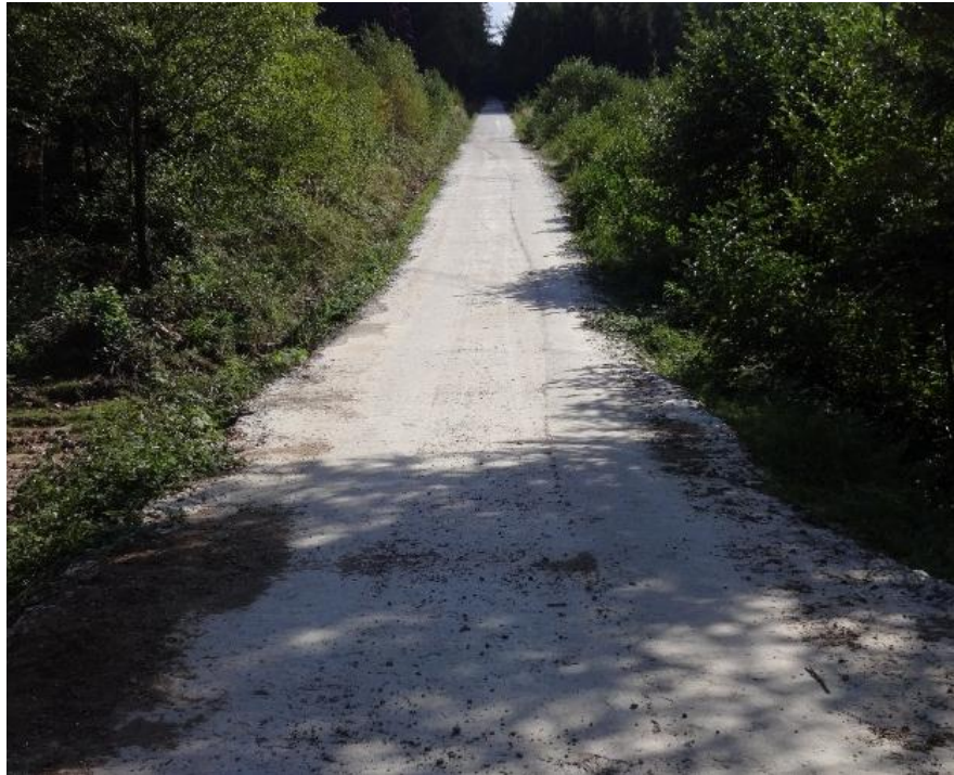
Obr. 39: Opravená lesní cesta Jelení palouky
