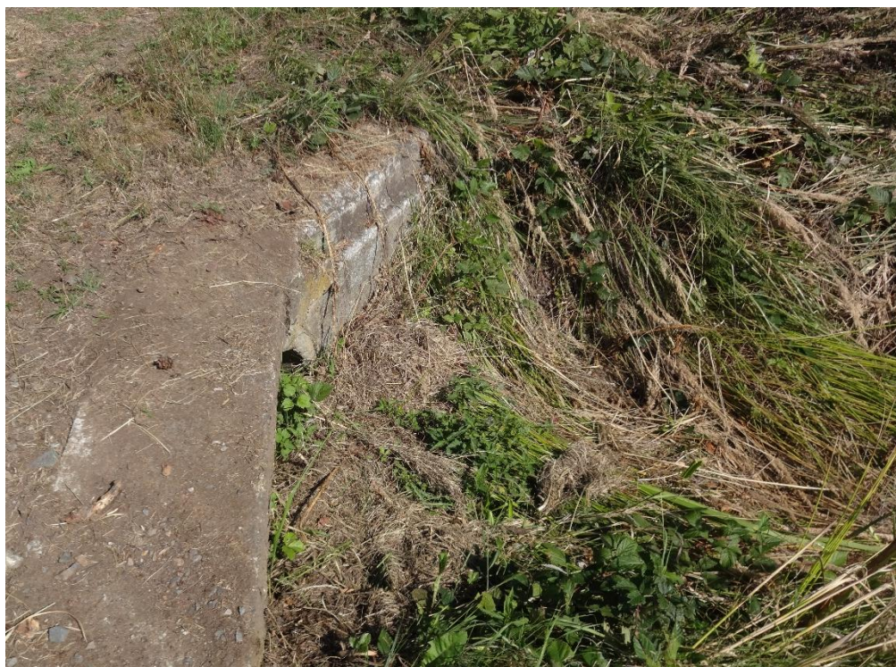
Obr. 38: Zanesený propustek na lesní cestě Vojenská
