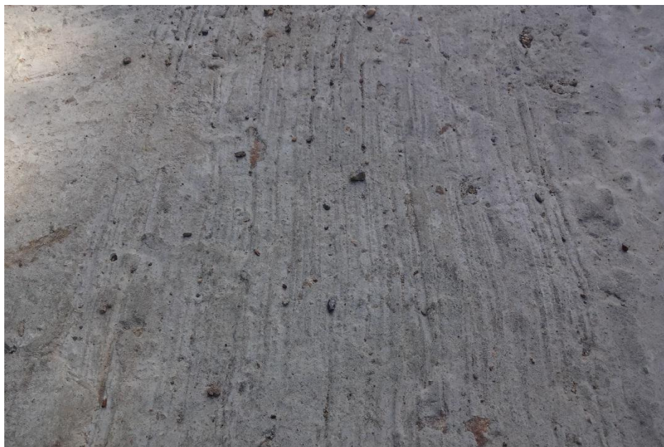
Obr. 41: Konečný povrch lesní cesty Jelení palouky
