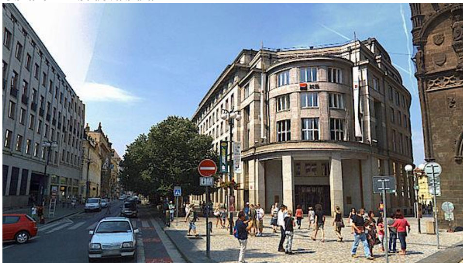
Obrázek 12 budova sídla KB
