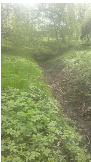
Obr. 29 – Vyschlý odpadní kanál před zaústěním do Labe [21]
