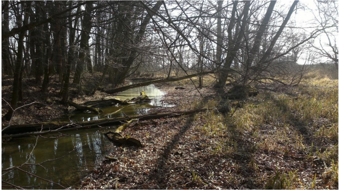
Obr. 32 – Odpadní kanál v zimním období [21]
