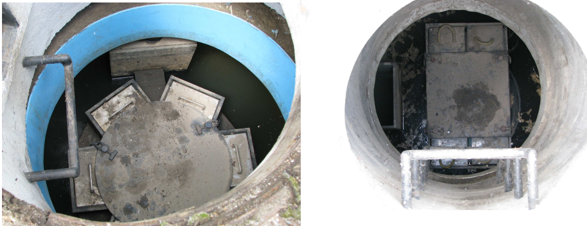
Obr. 2.12 – Koalescenční odlučovač lehkých kapalin
