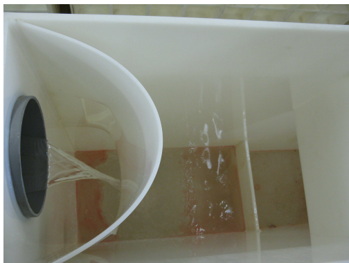
Obr. 4.3 – Odlučovač lehkých kapalin s prostou sedimentací
