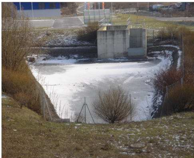
Obr. 2.19 – Řešení velkokapacitního parkoviště pomocí retenční nádrže a odlučovače (Pírek, 2007)
