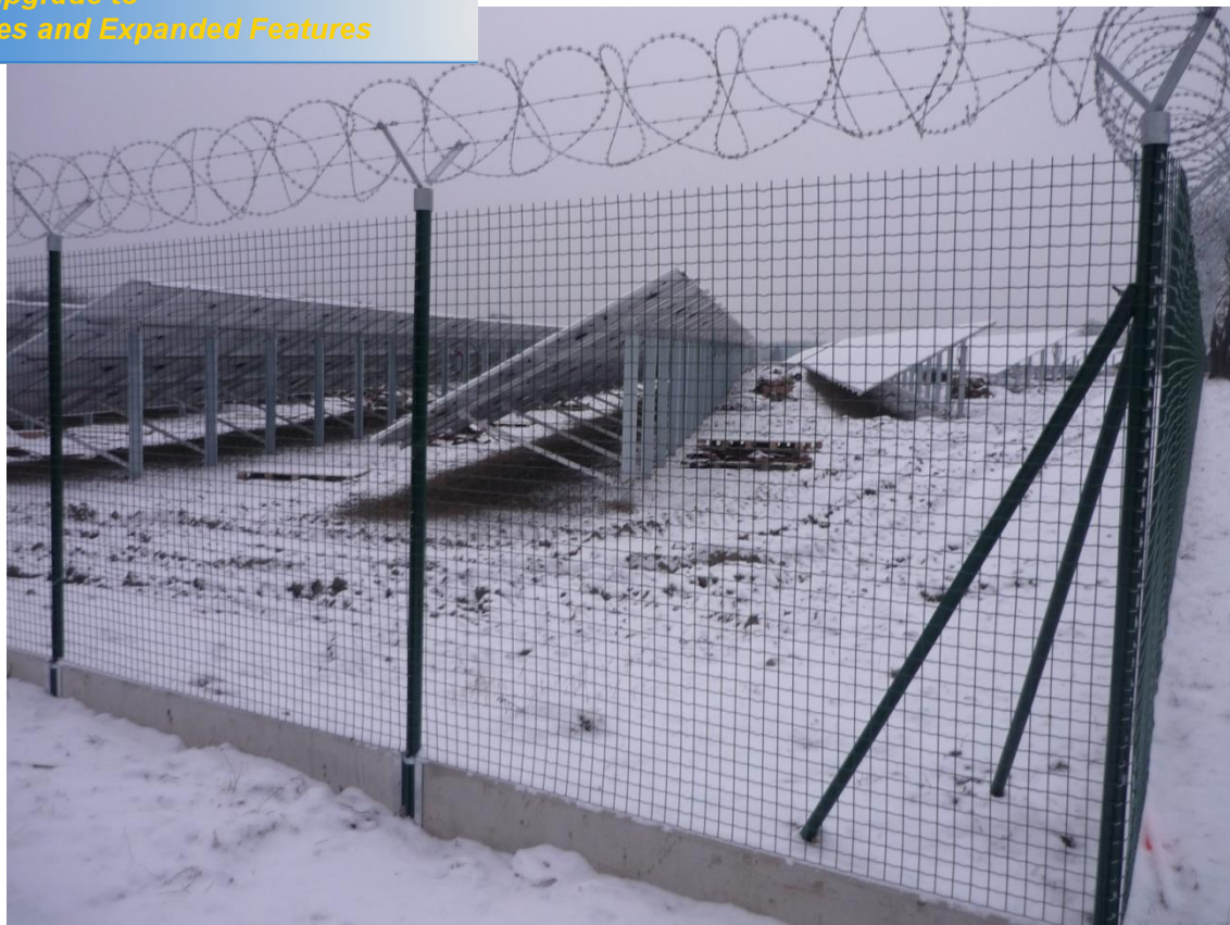
Foto 2 Fotovoltaická elektrárna ve výstavbě, umístění Bechyn, ve směru na Opavany
