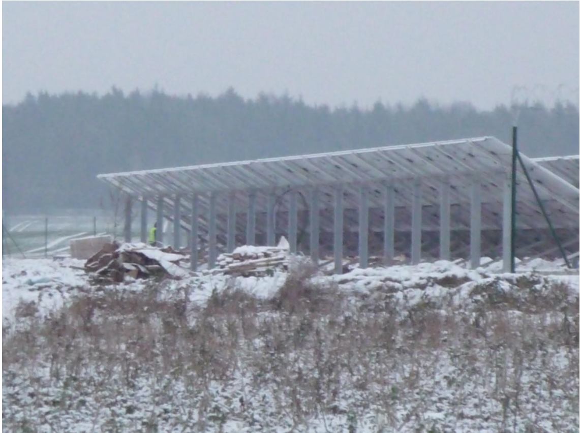
Foto 1 Fotovoltaická elektrárna ve výstavbě, umístění je u Bechyně, ve směru na Týn nad Vltavou
