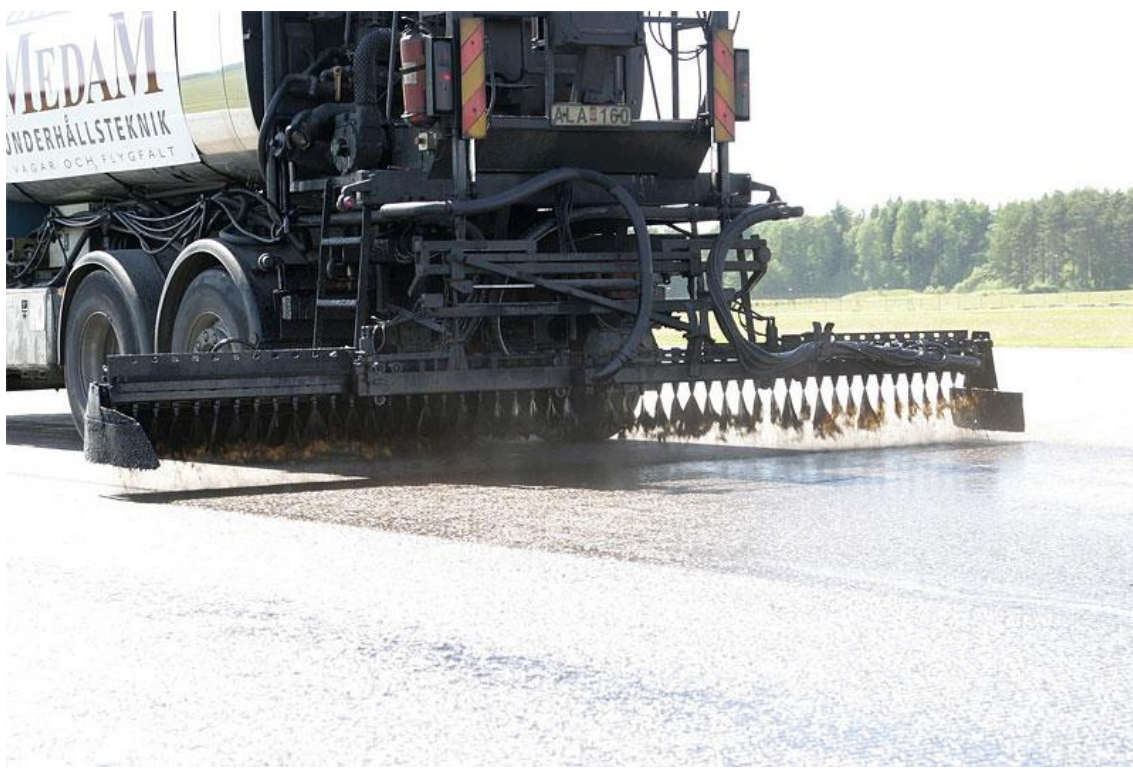
Obrázek 4-14: Provádění emulzního nátěru s použitím asfaltové emulze [52]
