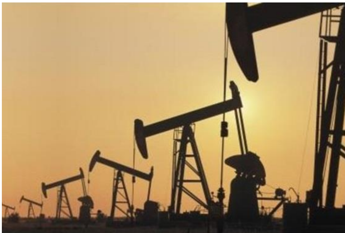
Obrázek 4-5: Pohled na hlubinná čerpadla ropného pole [48]
