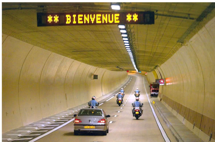
Obrázek 6-6: Směs s pojivem Bituclair, Toulon - tunel, Francie, rok 2002 [37]
