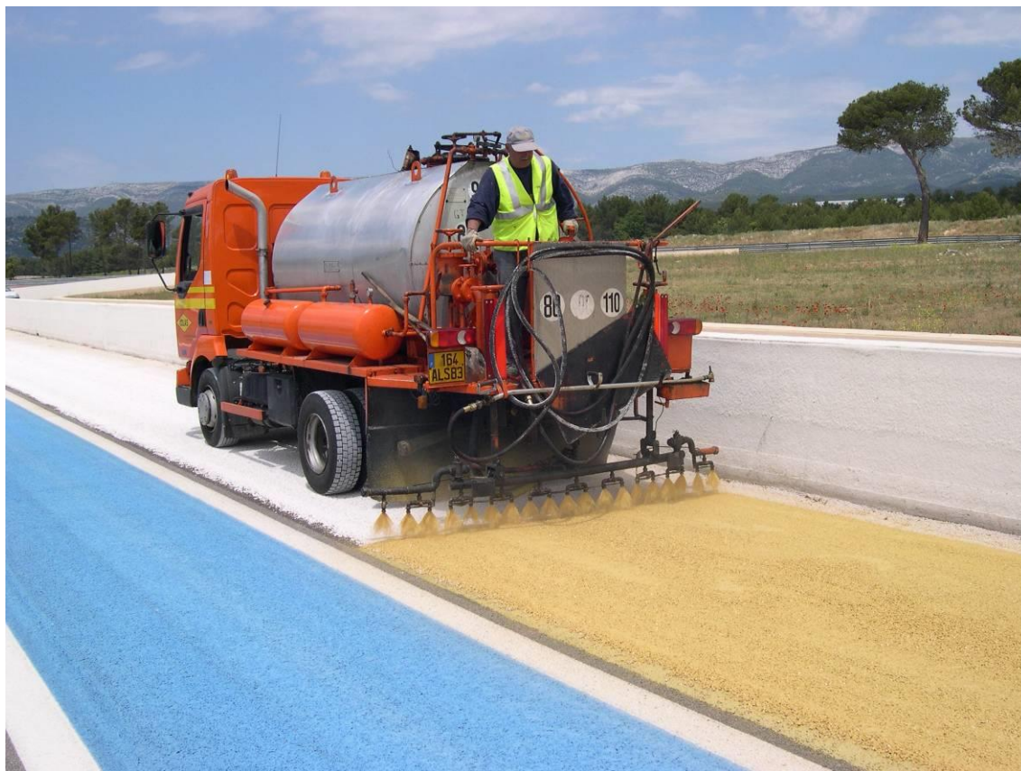
Obrázek 6-3: Aplikace emulzního nátěru s pojivem Végécol [37]
