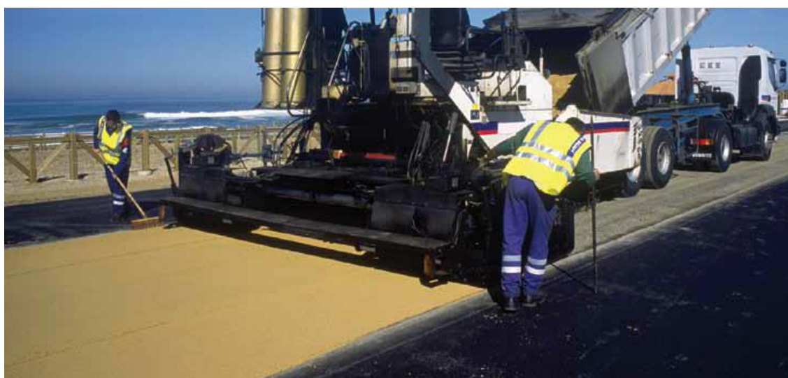
Obrázek 6-5: Pokládka směsi se syntetickým pojivem Shell Mexphalte C [11]
