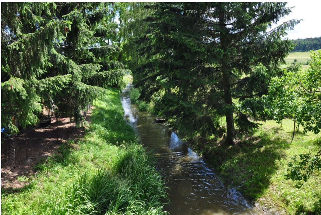
Foto č. 6: Točnický potok v Točníku – zpevněné koryto toku a nevhodná výsadba (Svobodová, 2016).
