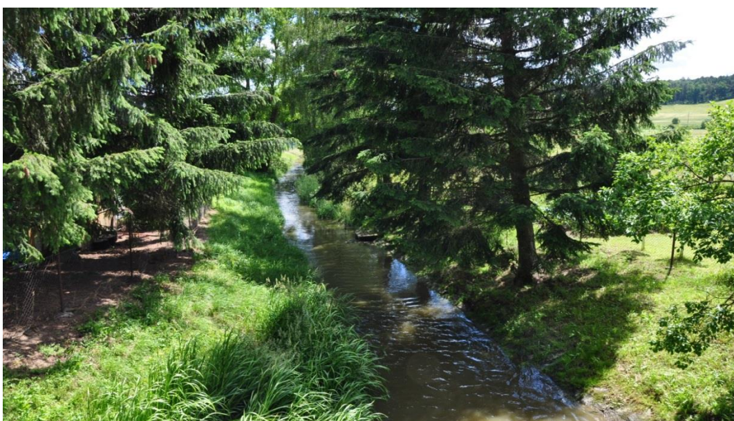
Obr. 8: Točnický potok (obec Vícenice) – upravený tok a nevhodná doprovodná zeleň (Svobodová, 2016).
