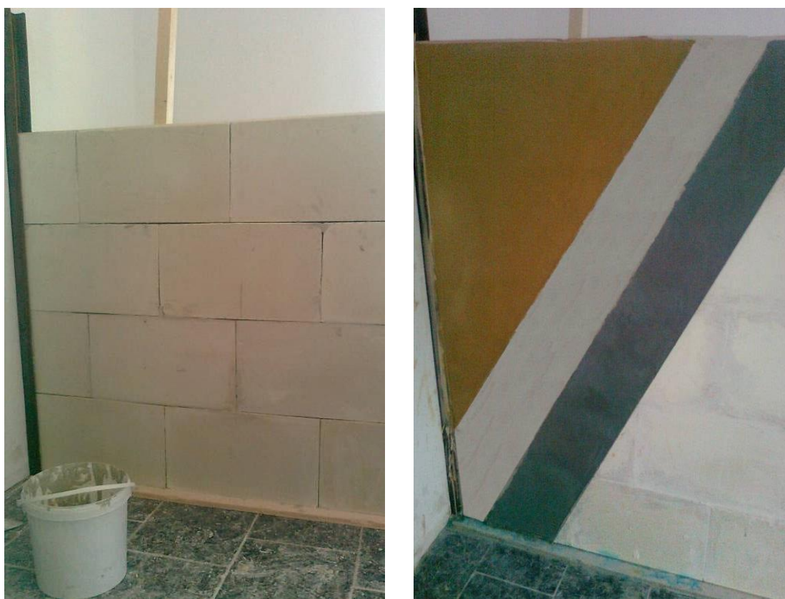
Obr. 54: Zdění příčky (vlevo), úprava povrchu sádrovým tmelem, sádrovou omítkou (vpravo)
