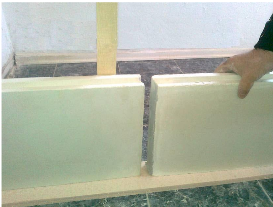
Obr. 53: Způsob spojování sádrových tvarovek
