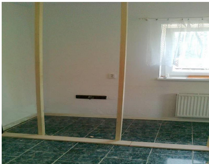
Obr. 52: Příprava pro zdění
