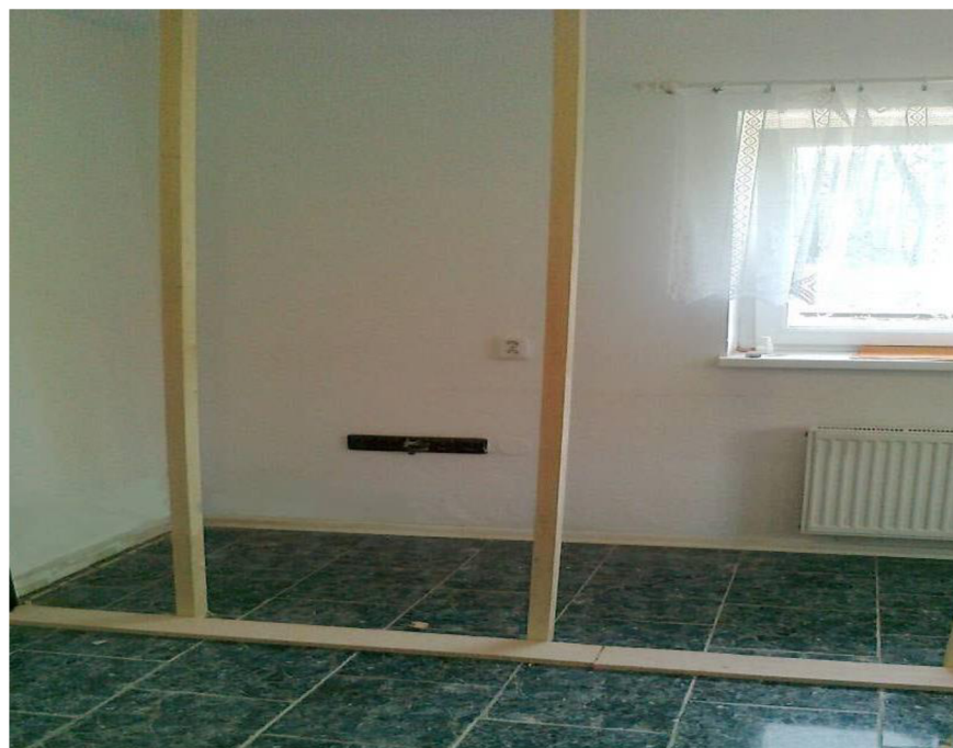
Obr. 52: Příprava pro zdění
