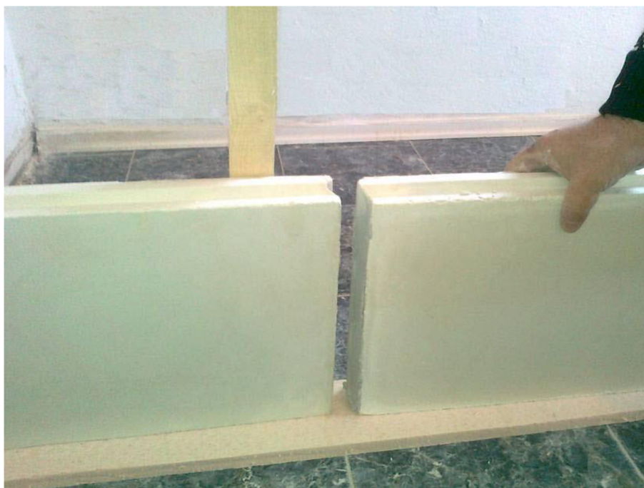
Obr. 53: Způsob spojování sádrových tvarovek
