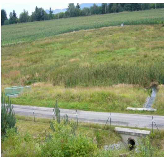
Obr.20: Nádrž a hráz s vozovkou
