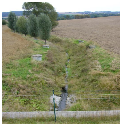
Obr.21: Odvod vody z poldru do kanálu
