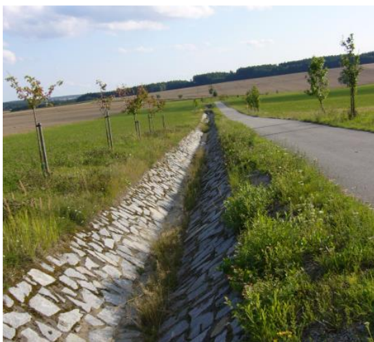
Obr. 46: Cesta s melioračním příkopem
