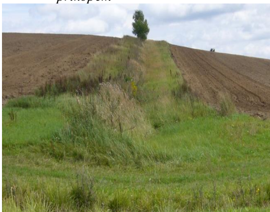
Obr. 32: Mez (horní) se záchytným příkopem
