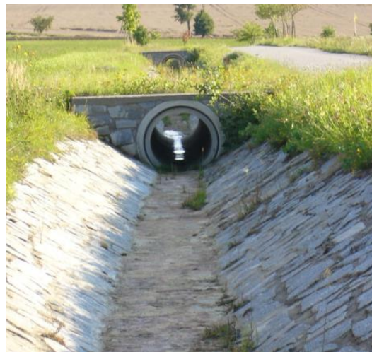
Obr. 47: Trubní přejezd
