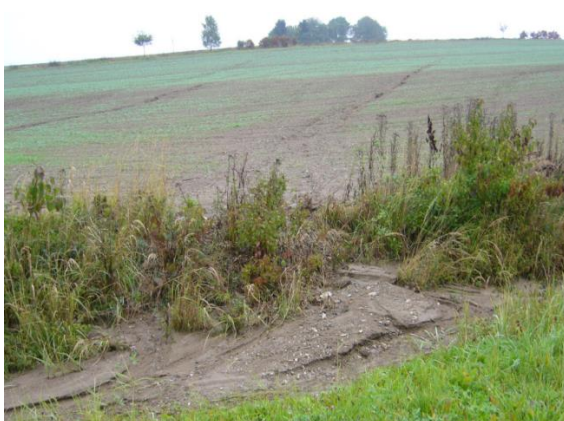
Obr. 37: Projevy eroze – pole nad dolní mezí
