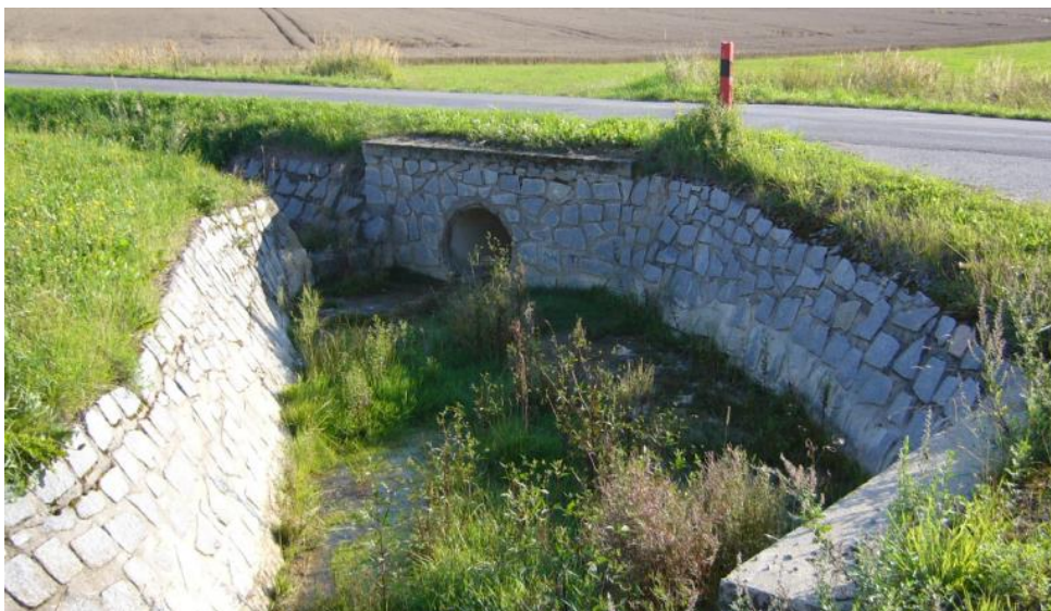
Obr. 48: Silniční propustek v dolní části melioračního příkopu
