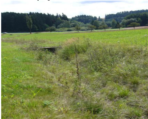
Obr. 34: Odvodňovací příkop s trubním přejezdem
