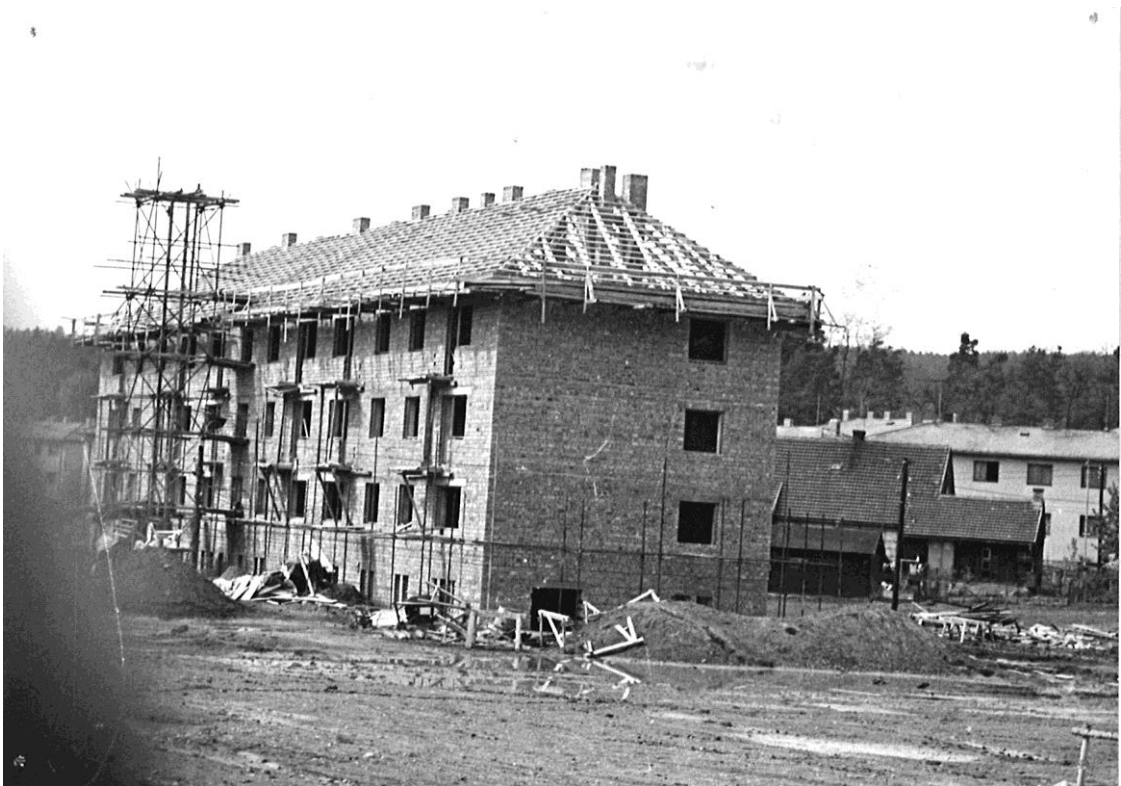
[Obr. 8] Týnec nad Sázavou, výstavba sídliště, 50. léta 20. století.
