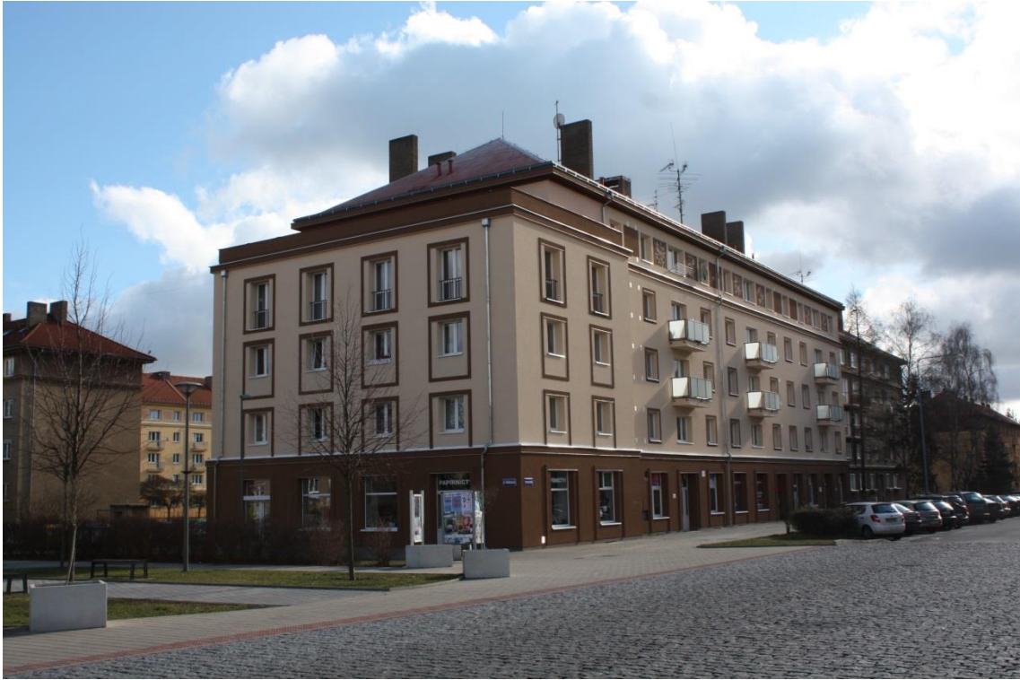
[Obr. 47] Kladno-Kročehlavy, zateplení č. p. 1984, 1985.
