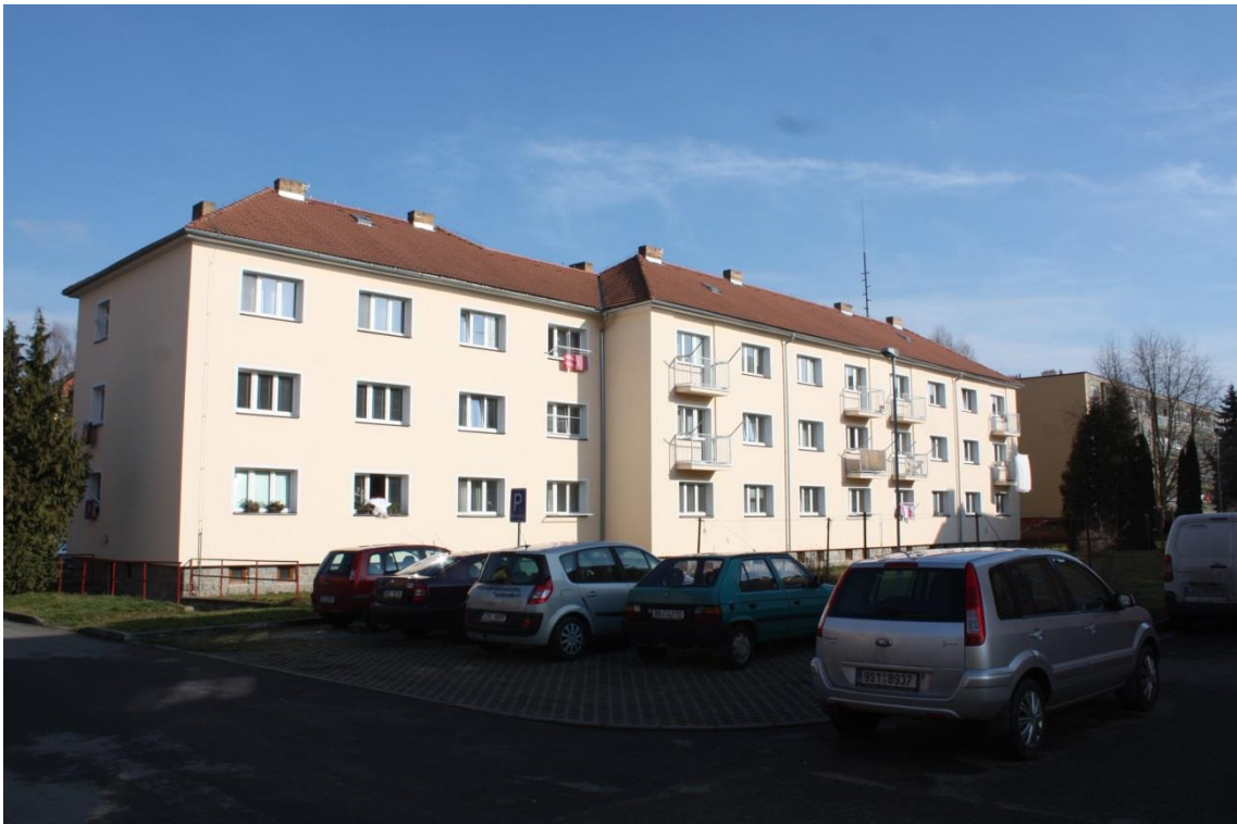
[Obr. 29] Týnec nad Sázavou, zateplení č. p. 285, 286, 287, 288.
