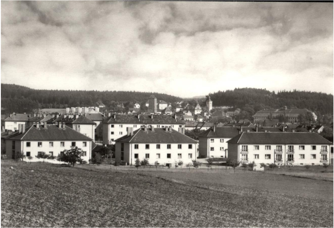
[Obr. 9] Týnec nad Sázavou, sídliště, 50. léta 20. století.
