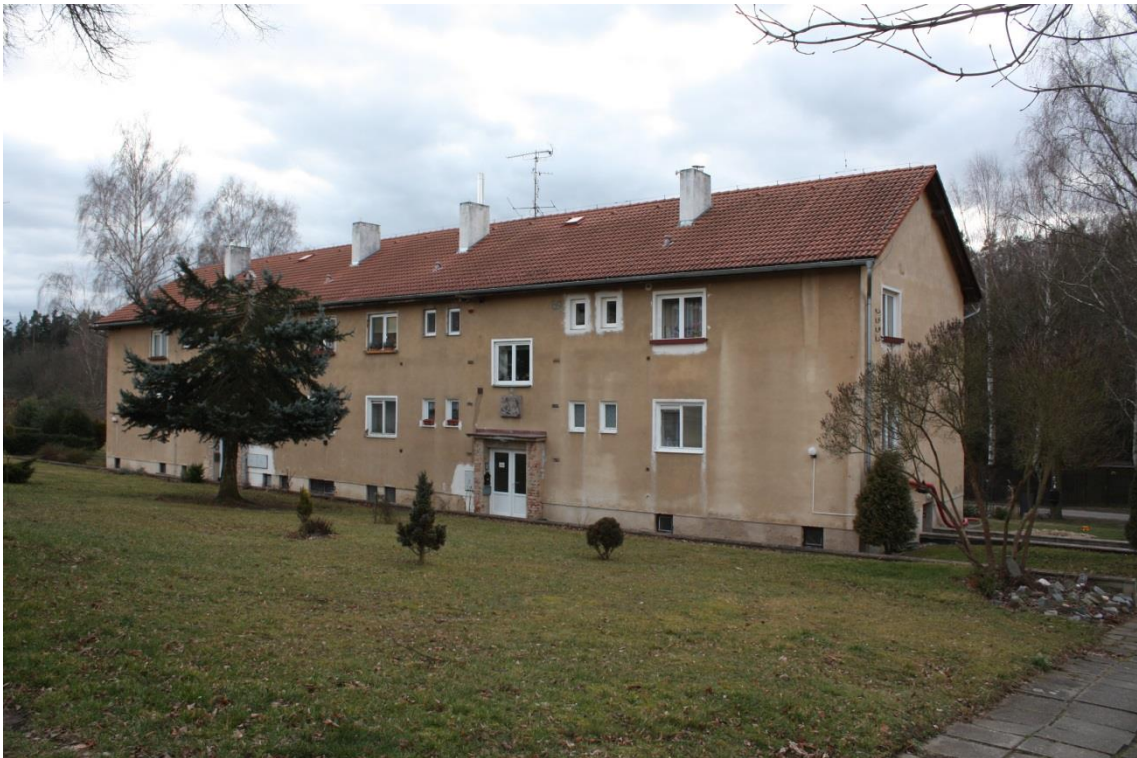
[Obr. 53] Chrást nad Sázavou, č. p. 212, 213.
