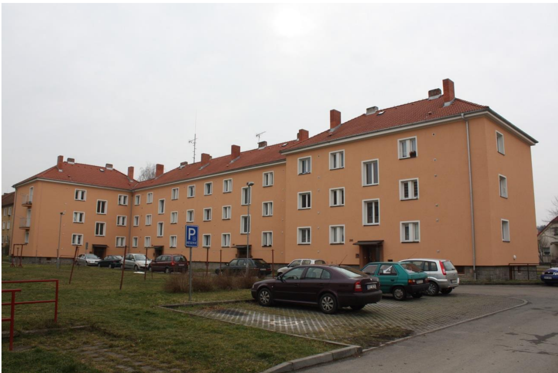
[Obr. 30] Týnec nad Sázavou, zateplení č. p. 289, 290, 292, 293.
