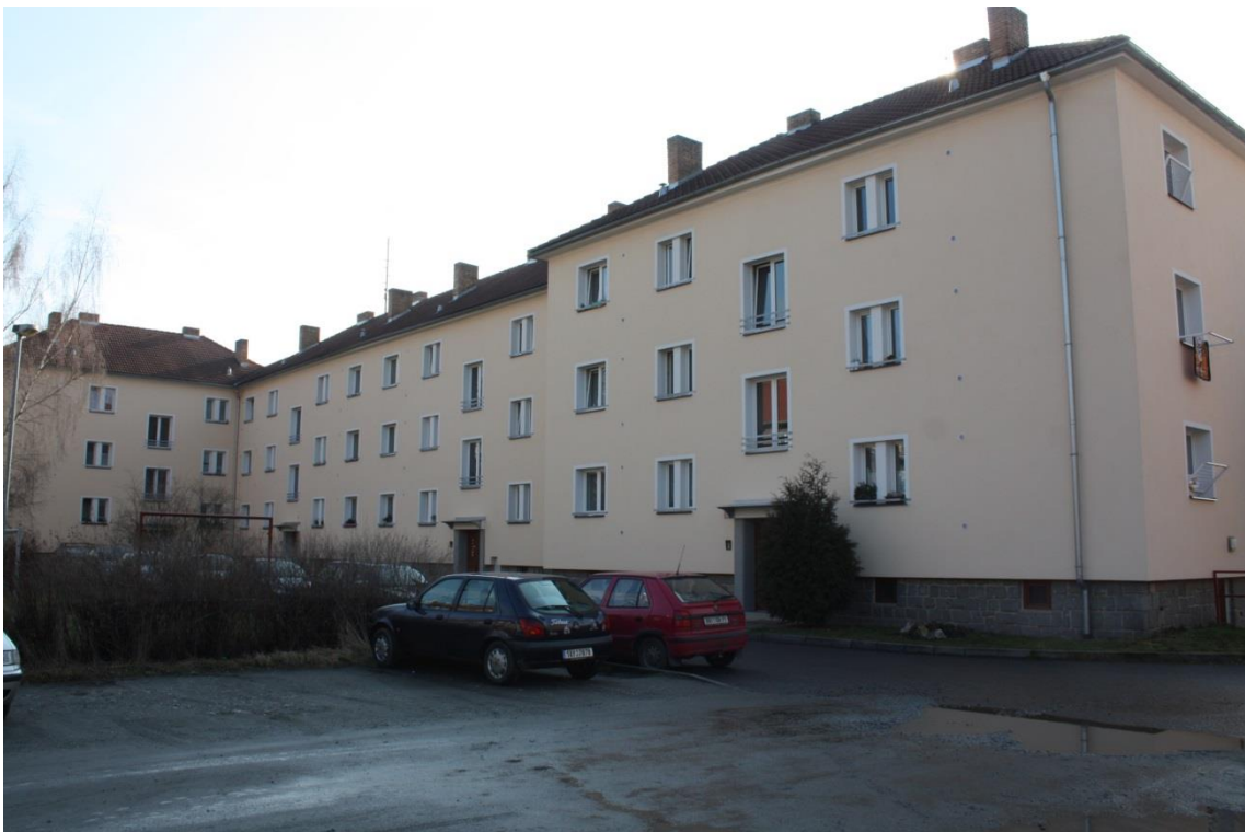
[Obr. 28] Týnec nad Sázavou, zateplení č. p. 285, 286, 287, 288.
