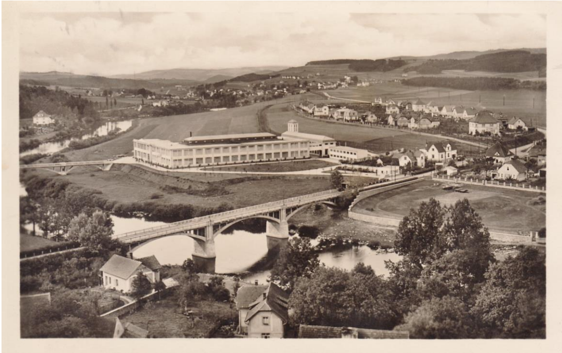
[Obr. 7] Týnec nad Sázavou, pohled na slévárnu, 30. léta 20. století.
