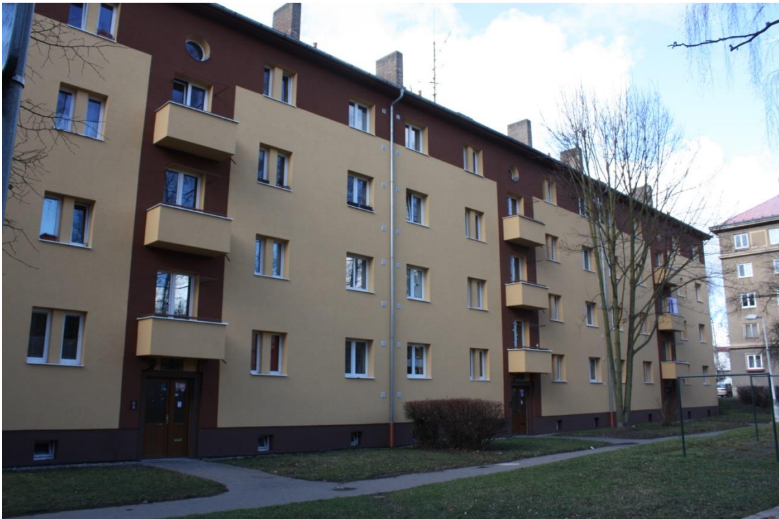
[Obr. 49] Kladno-Kročehlavy, zateplení č. p. 1988, 1989, 1990.
