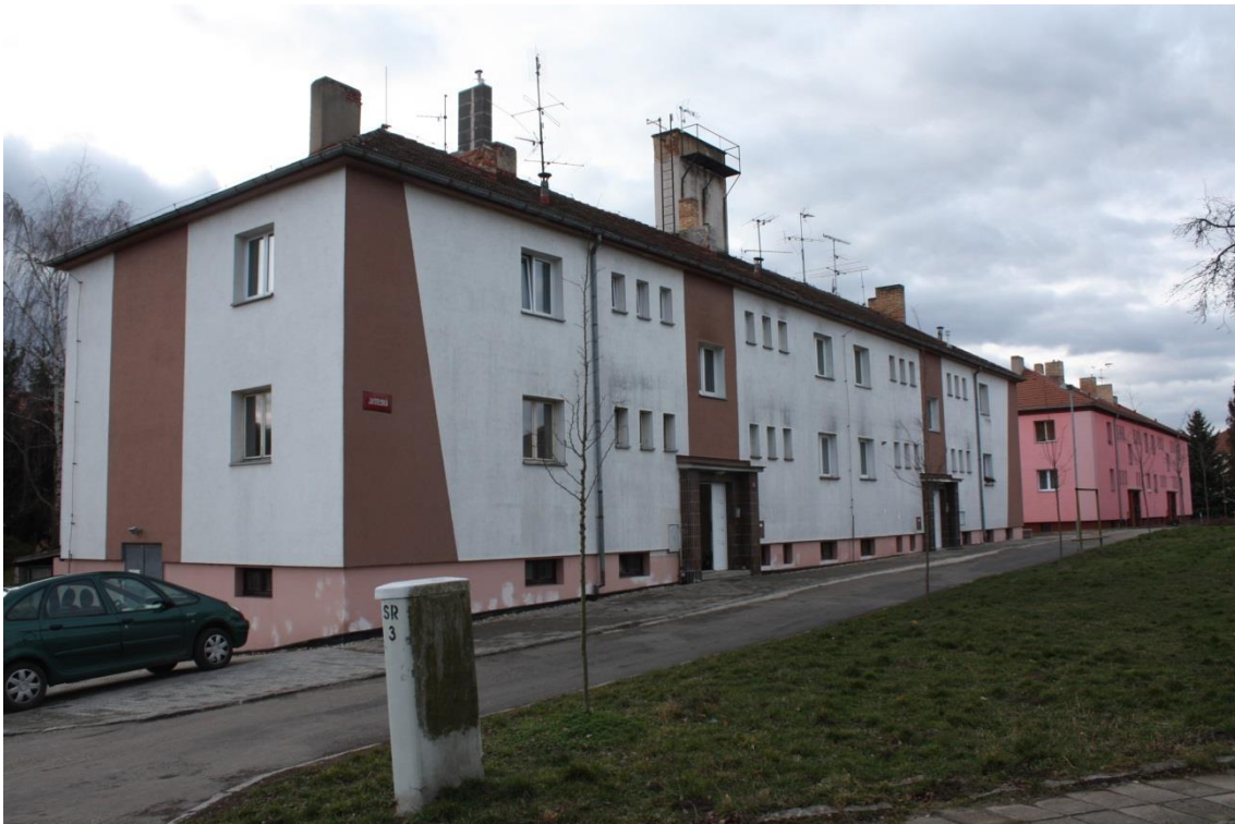
[Obr. 60] Chrást nad Sázavou, zateplování staveb v ulici Jaselská.
