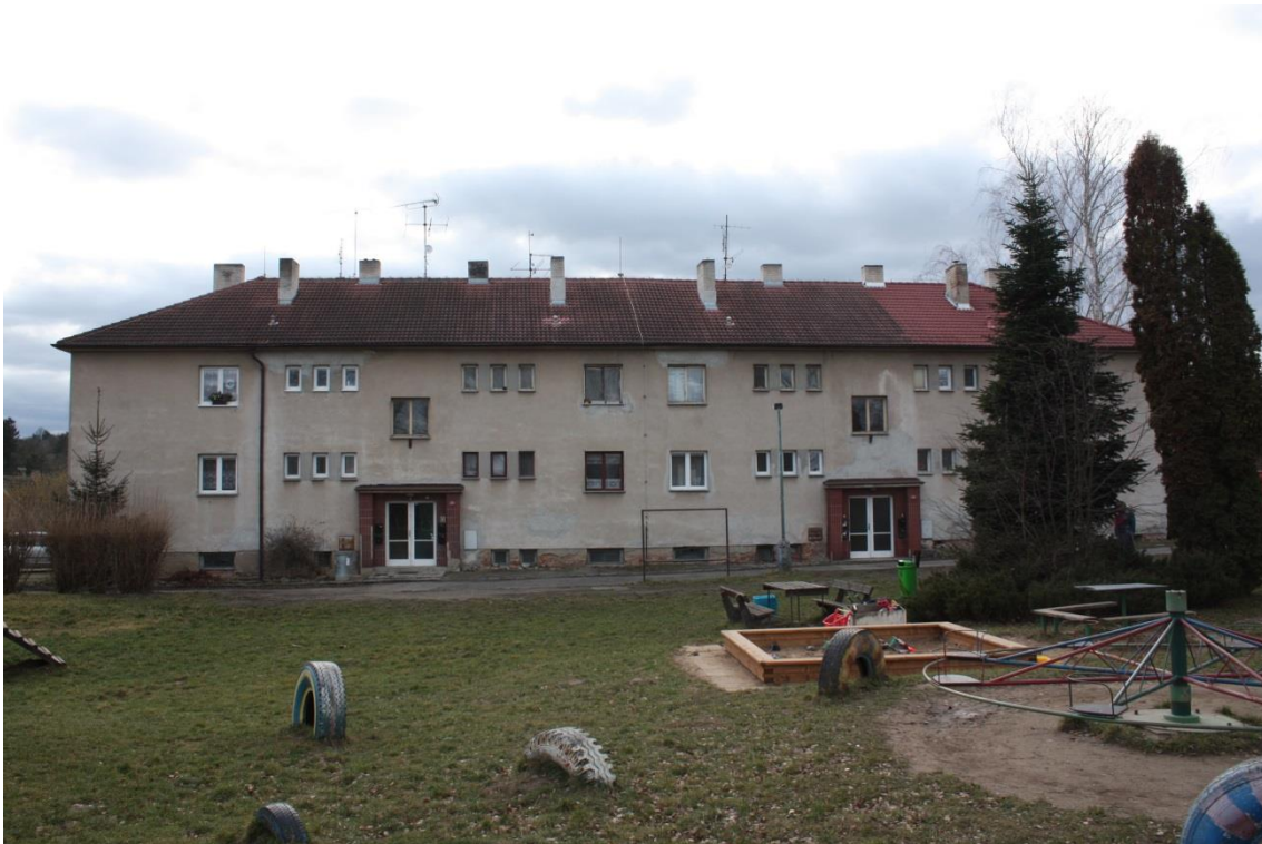
[Obr. 58] Chrást nad Sázavou, č. p. 232, 233.
