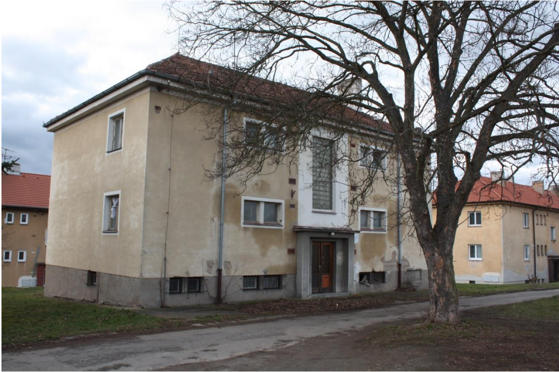
[Obr. 55] Chrást nad Sázavou, č. p. 227.
