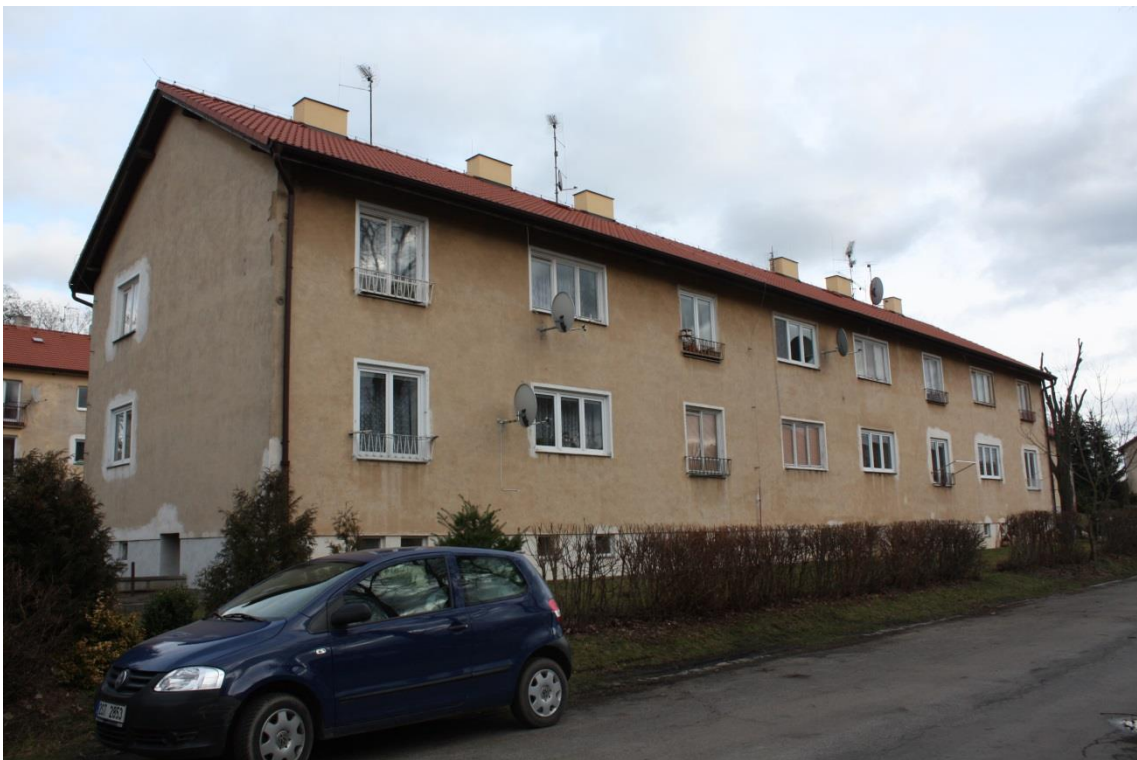
[Obr. 54] Chrást nad Sázavou, č. p. 212, 213.
