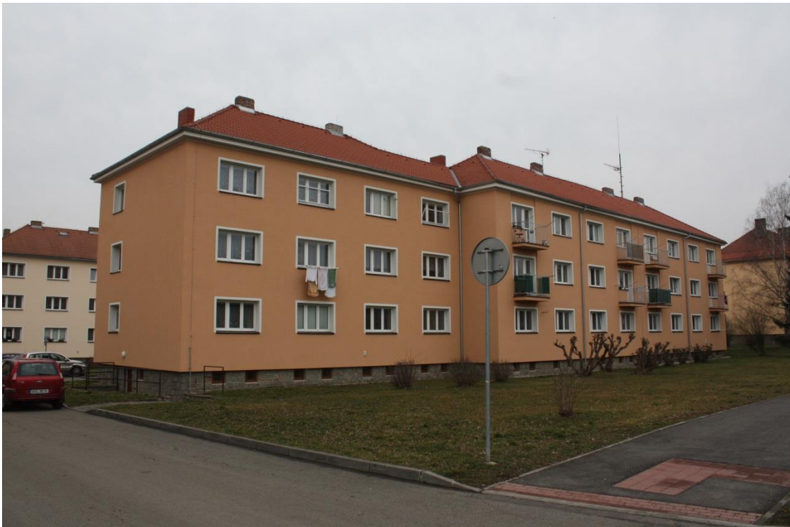
[Obr. 31] Týnec nad Sázavou, zateplení č. p. 289, 290, 292, 293.
