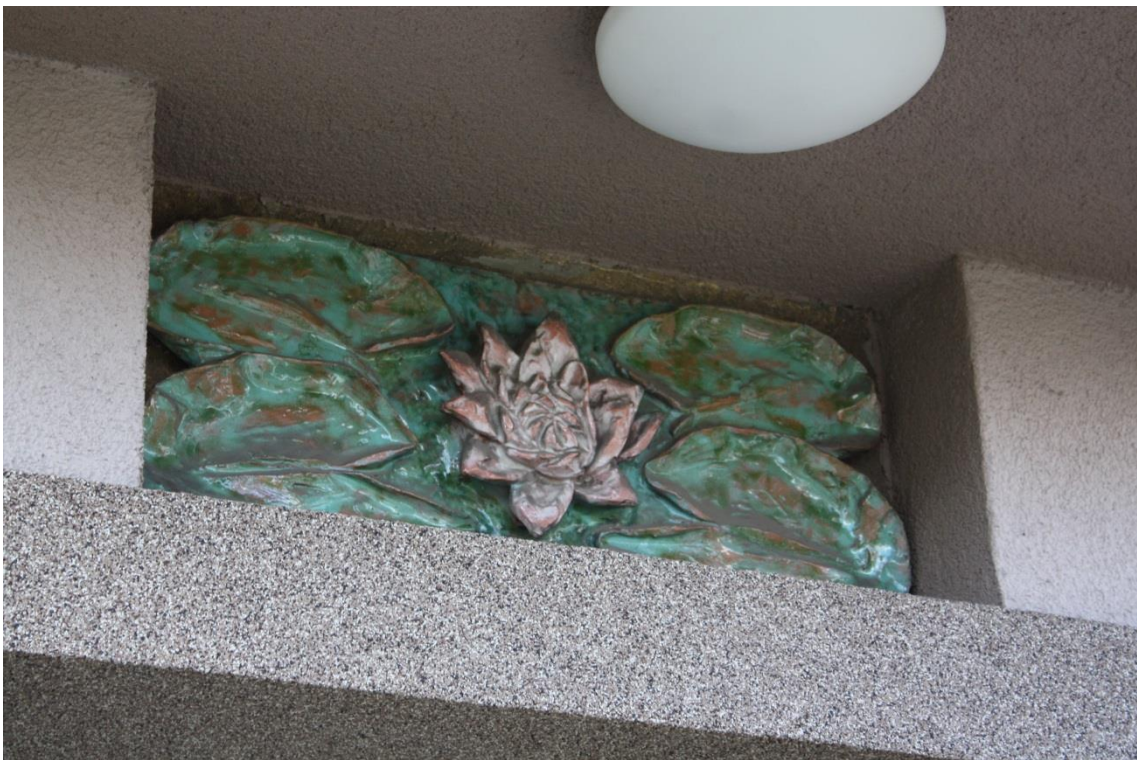
[Obr. 50] Kladno-Kročehlavy, domovní znamení na zatepleném č. p. 2012.
