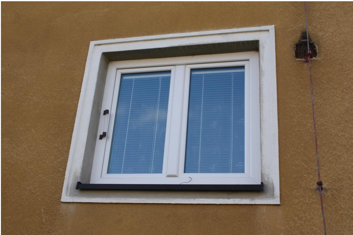
[Obr. 26] Týnec nad Sázavou, okenní šambrány č. p. 262, 263, 264.
