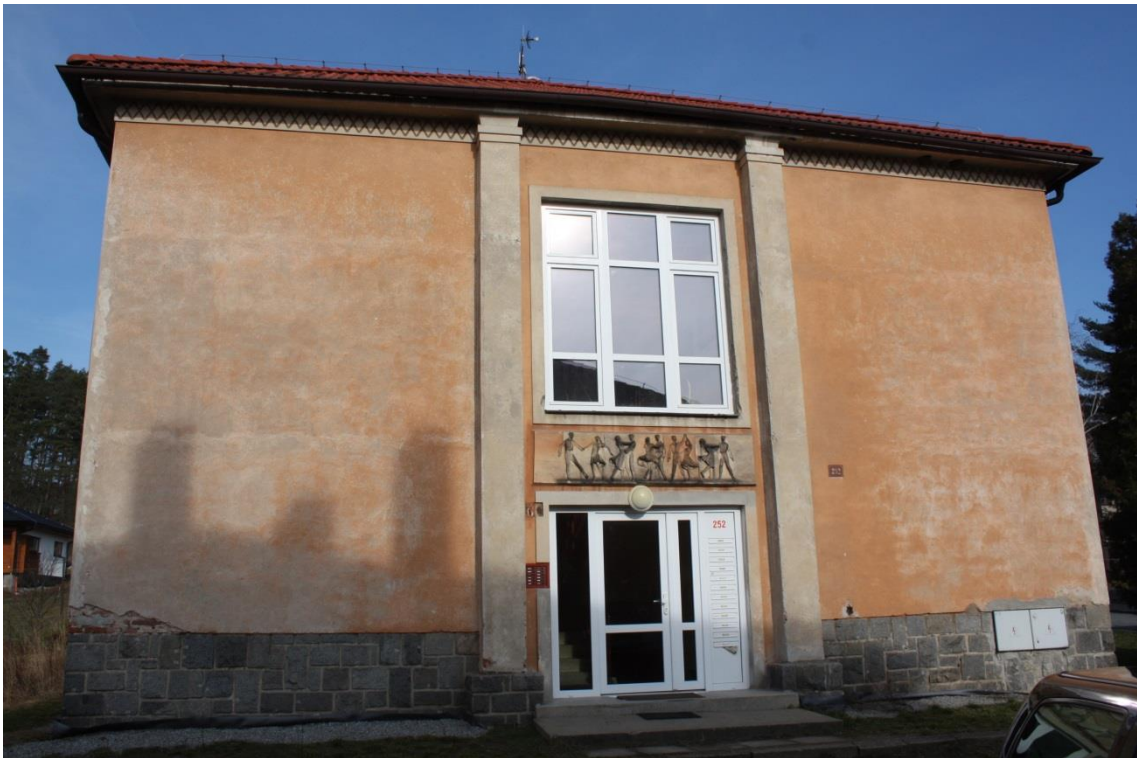
[Obr. 16] Týnec nad Sázavou, průčelí č. p. 252.
