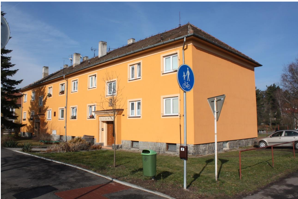
[Obr. 20] Týnec nad Sázavou, zateplení č. p. 258, 259.
