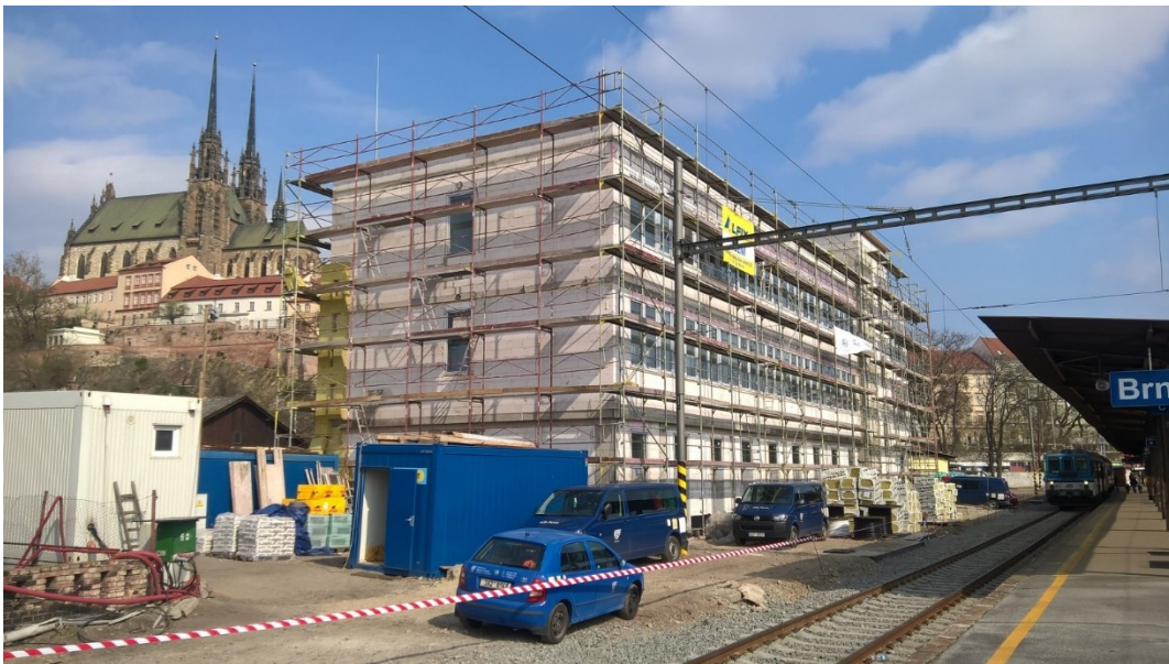
Obr. 2.2 Technologická budova Brno hlavní nádraží
