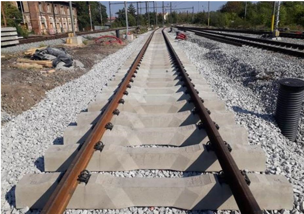
Obr. 1.8 Úprava železničního svršku Brno dolní nádraží
