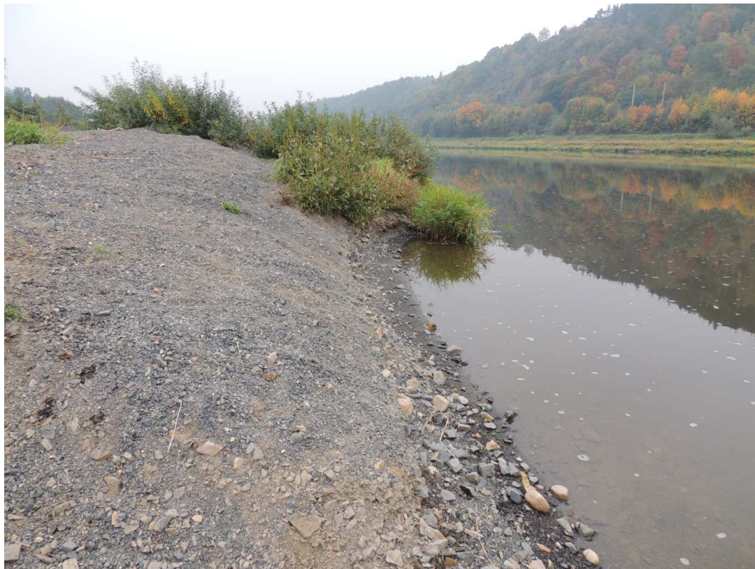
Fotografie č.3: Navážka navezená na vymletý břeh po povodni, cca v místě PF8
