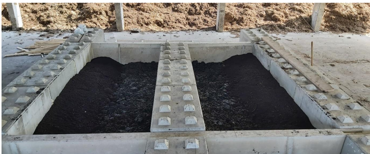
Obrázek č. 9: Vermikompostovací zakládky v betonových kójích (foto Milan Hrčka)
