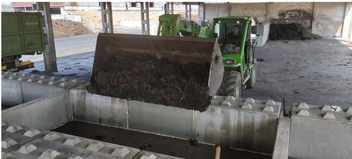
Příloha č. 3: Zakládání první vrstvy (foto Milan Hrčka)
