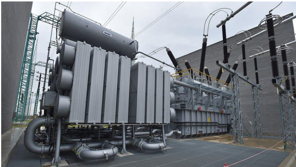
Obrázek 4: Jeden z PST transformátorů v Hradci u Kadaně [36]
