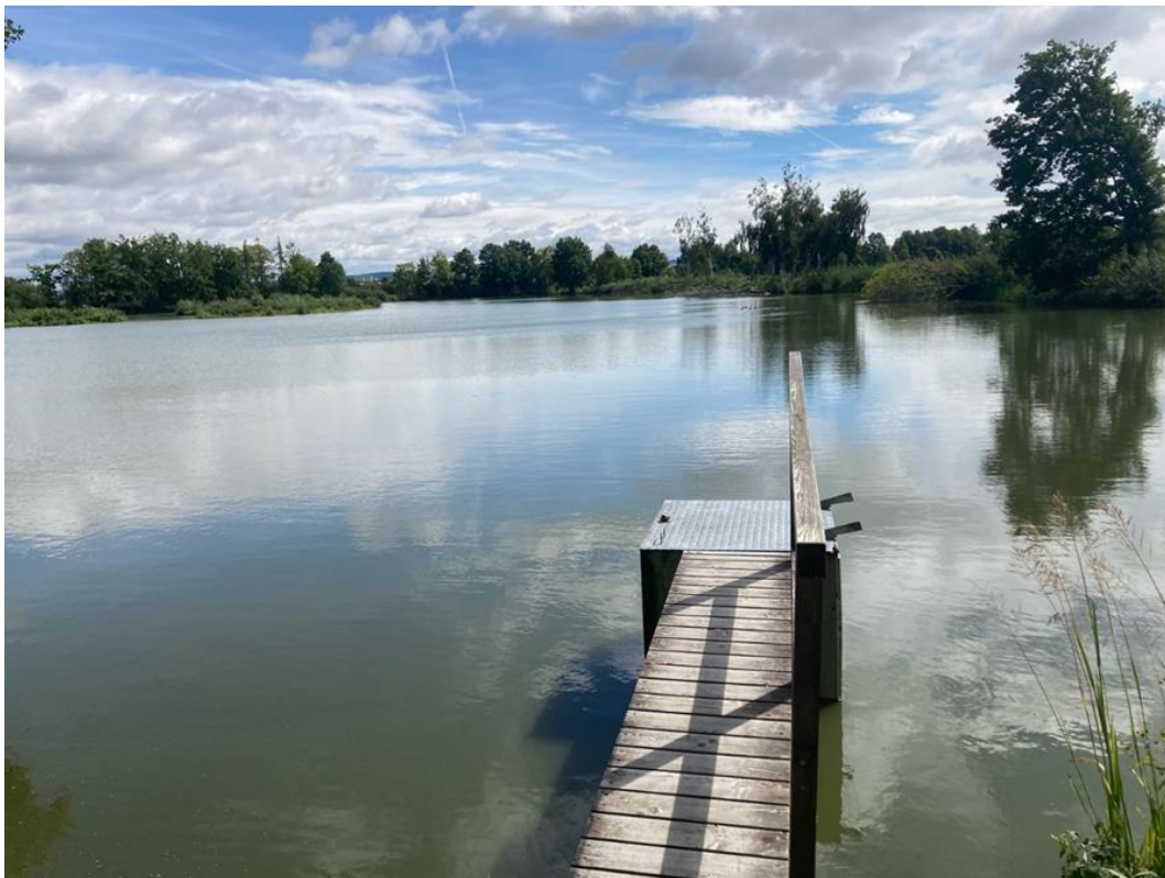
Příloha č. 15: Výpustní zařízení na r. Bažina, zároveň plnilo i účel pro měření parametrů (1.9.2023, foto: autor)
