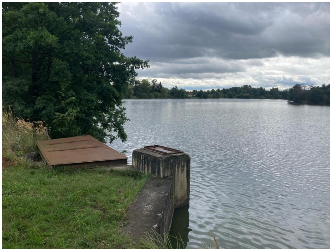
Příloha 17: Betonové stavidlo r. N. Vrbenský, také místo pro měření parametrů (1.9.2023, foto: autor)
