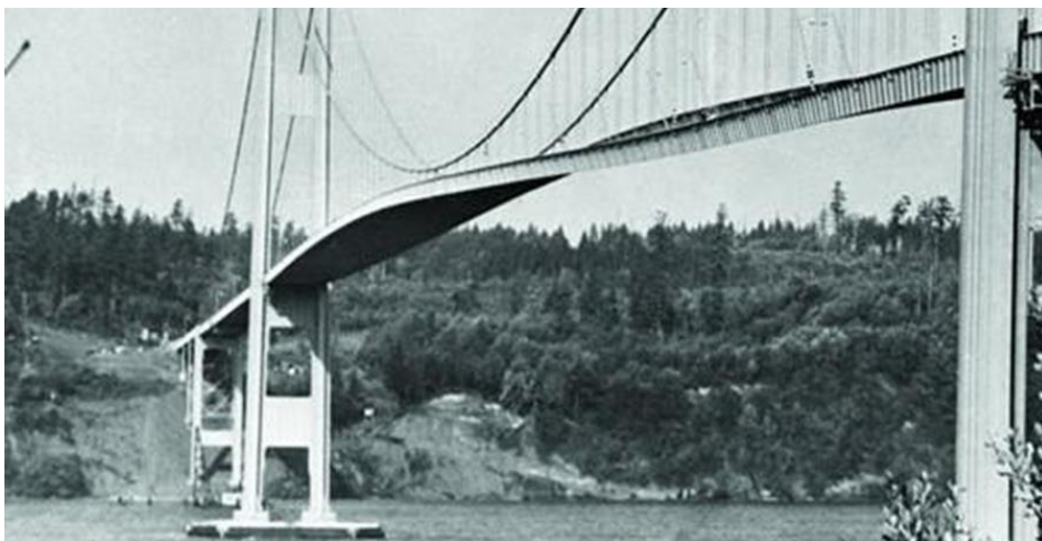
Obrázek 4.2: Deformovaný most přes úžinu Tacoma těsně před kolapsem [31]
