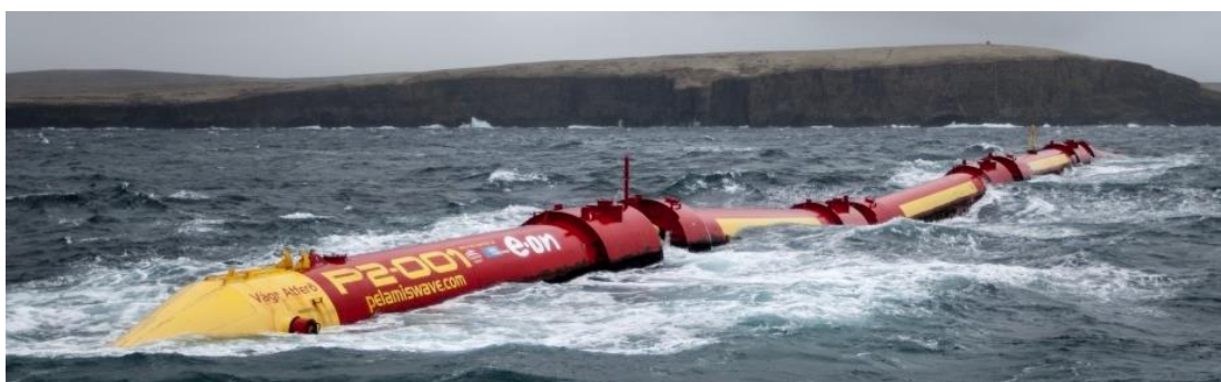
Obrázek 2.7: Aplikace systému Pelamis P2 o výkonu 0,75 MW u pobřeží Skotska [15]
