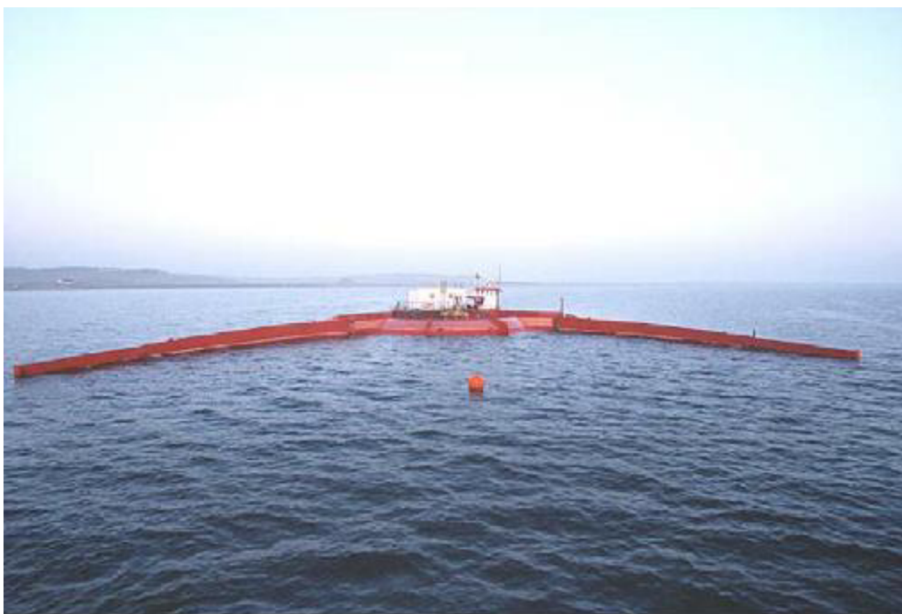
Obrázek 2.4: Konkrétní aplikace přepadového zařízení od firmy Wave Dragon [12]
