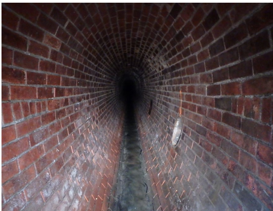
Obr. č. 34: Pohled do stoky v ulici Poděbradská od Š09 směrem po toku (Sismilich, 2018).
