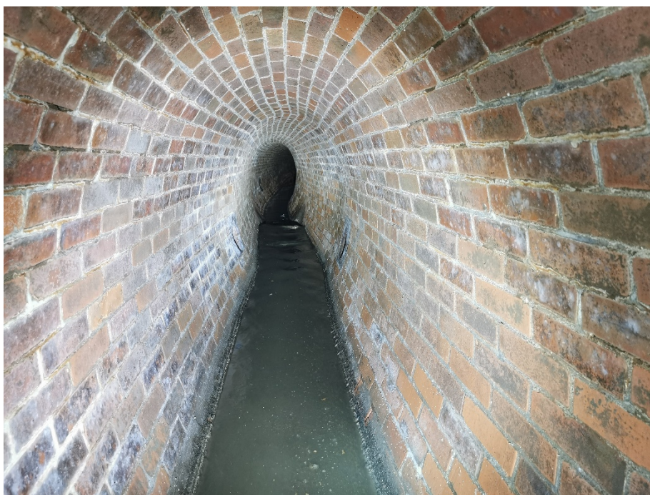
Obr. č. 28: Pohled do stoky v ulici Na Stírce od šachty Š26 směrem po toku (Sismilich, 2021).
