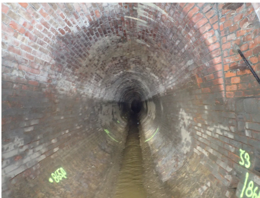
Obr. č. 26: Pohled do stoky v ulici U Seřadiště od Š03 po toku (Sismilich, 2019).
